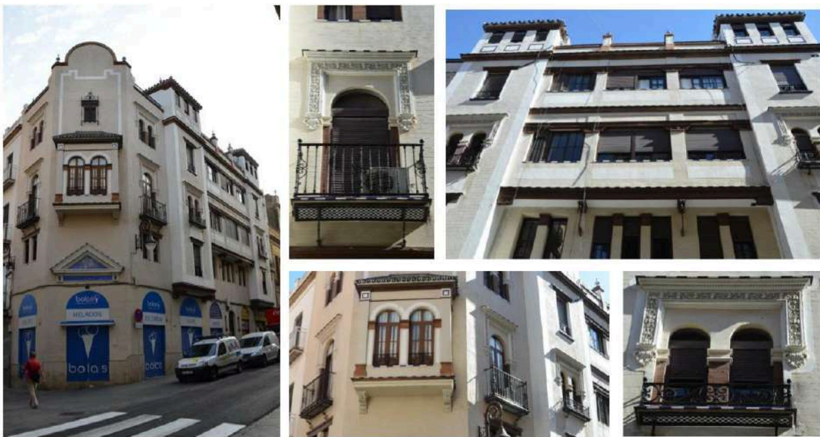
1924-25 Casa de viviendas para Luciano Martínez Díez. Calle Relator, no 56 esq. C/San Basilio
