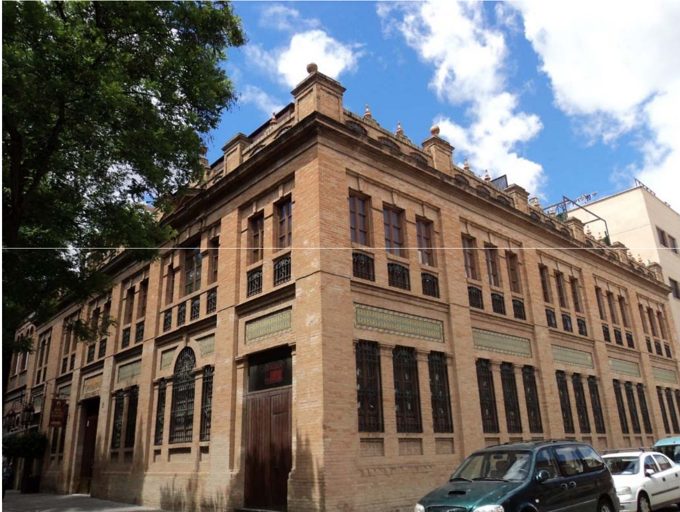
Fábrica de Sedas de Sevilla, en la avenida de Miraflores, de 1916-1917.
