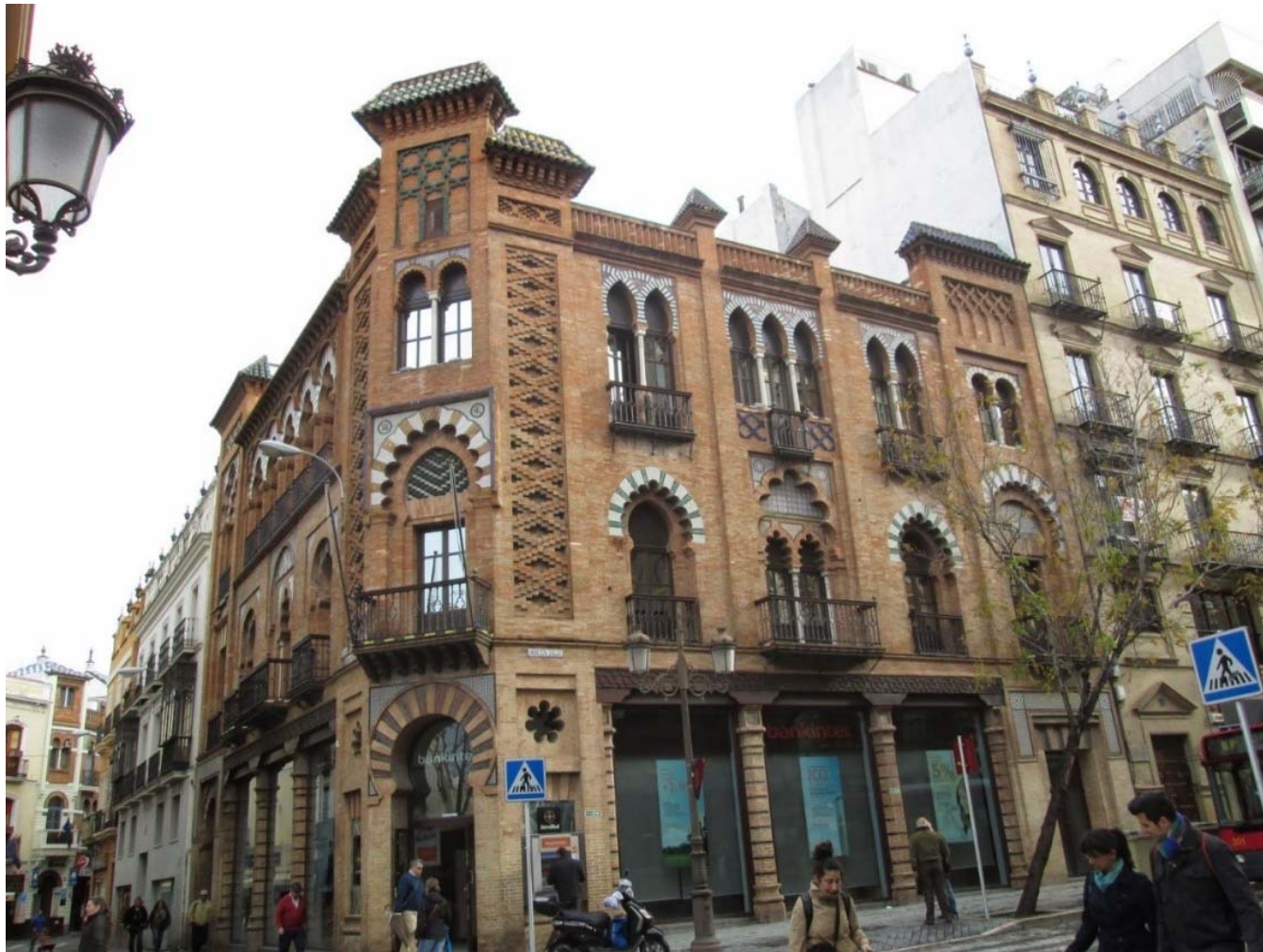
Edificio de viviendas y comercio, calle Martín Villa nº 6 de Sevilla (1907-1908)
