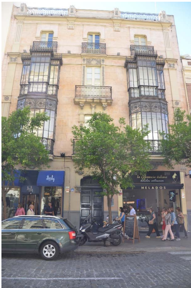
Casa Grosso, c/ San Pablo, nº3, entre 1908-1909
