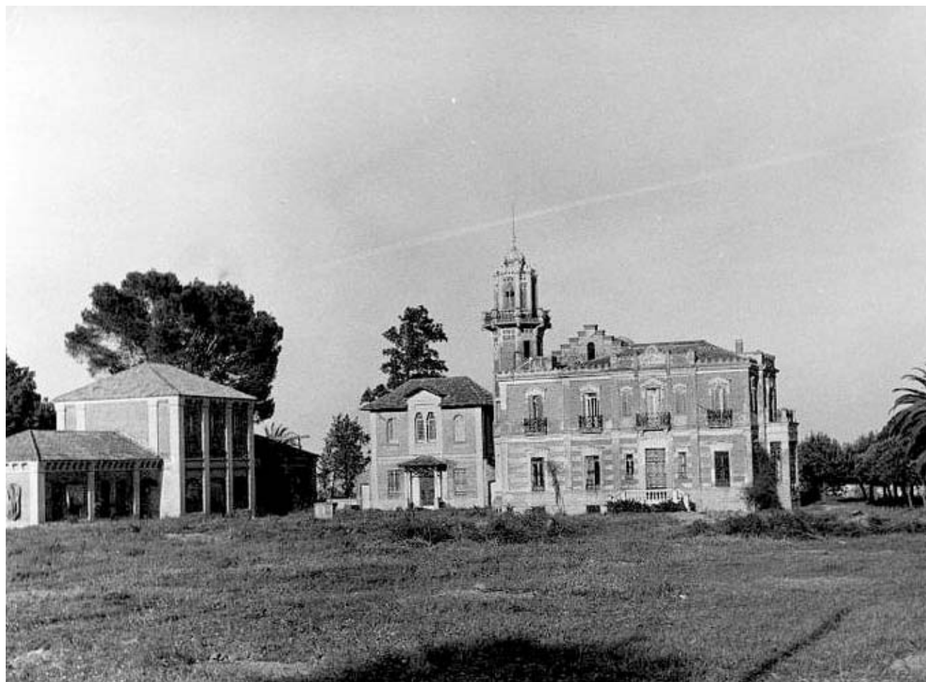
Casa-hacienda de Santa Teresa de Buena Vista, Ctra. Sevilla-Castilleja de la Cuesta (1904) en colaboración con José Gómez Otero. Demolida
