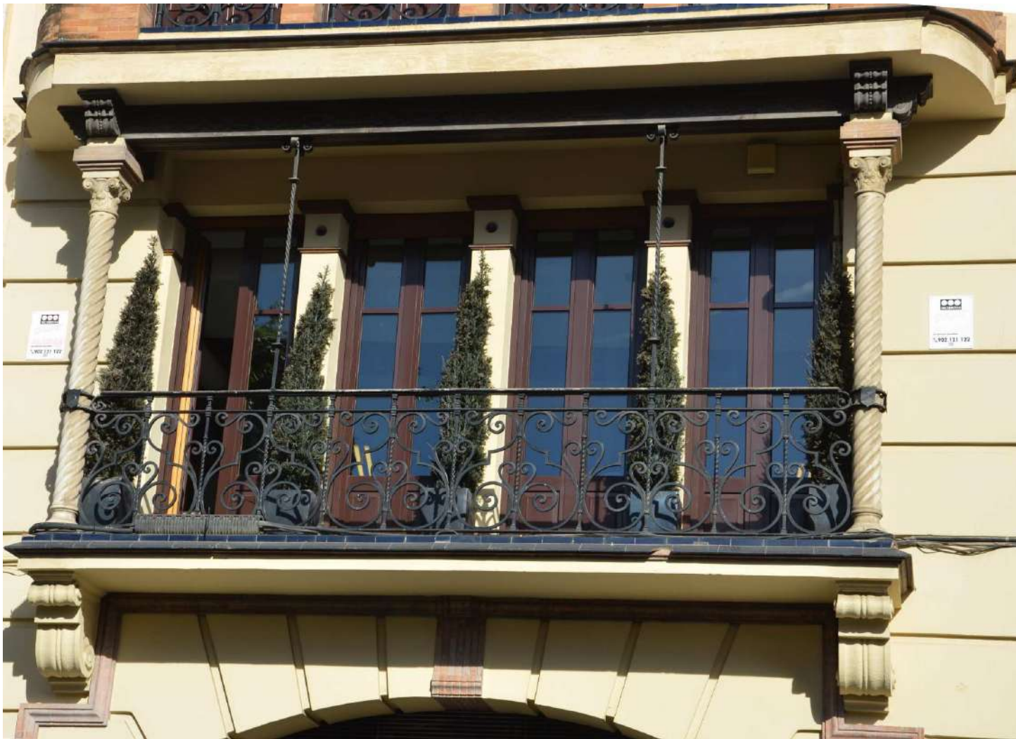
1927-28 Casa de viviendas para Ricardo Luque. Calle Santo Tomás, nº 4 (fachada trasera de Tomás de Ybarra, nº 15)
