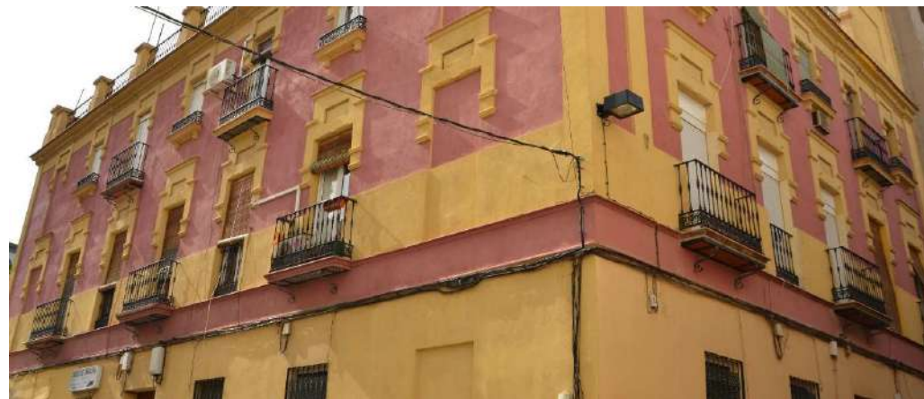
1912 Casa para Manuel García. Calle Recaredo esq. Lechamarzo
