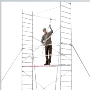
Elevador Hymer-Lifter en el montaje.
