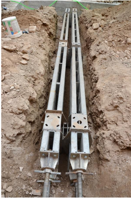
Sistema Soldier MKII, como puntales horizontales de altas cargas para el apuntalamiento de muros pantalla de un sótano
