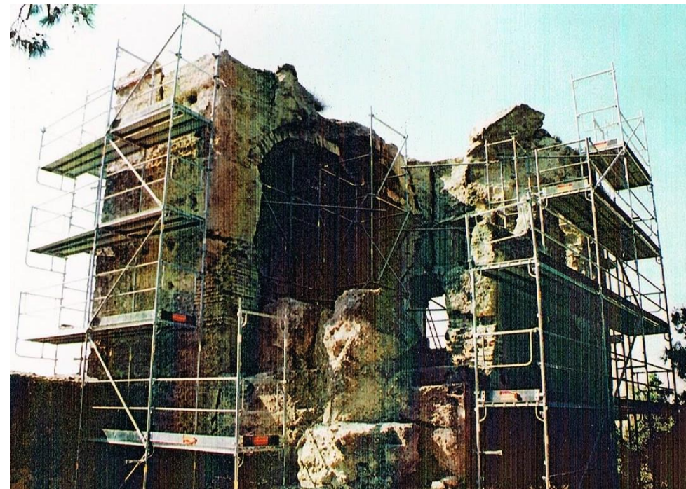
Andamio para consolidación de los muros y apuntalamiento de bóvedas en la torre del Castillo Luna de Mairena del Alcor.
