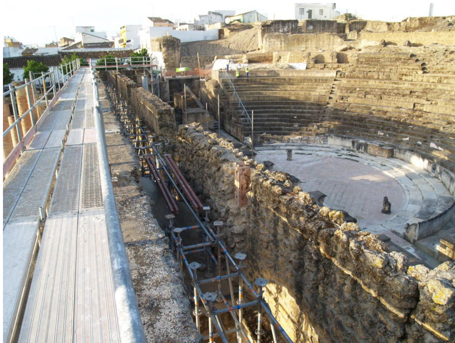
Apuntalamiento para creación de una losa de atado en el Teatro Romano de Itálica.
