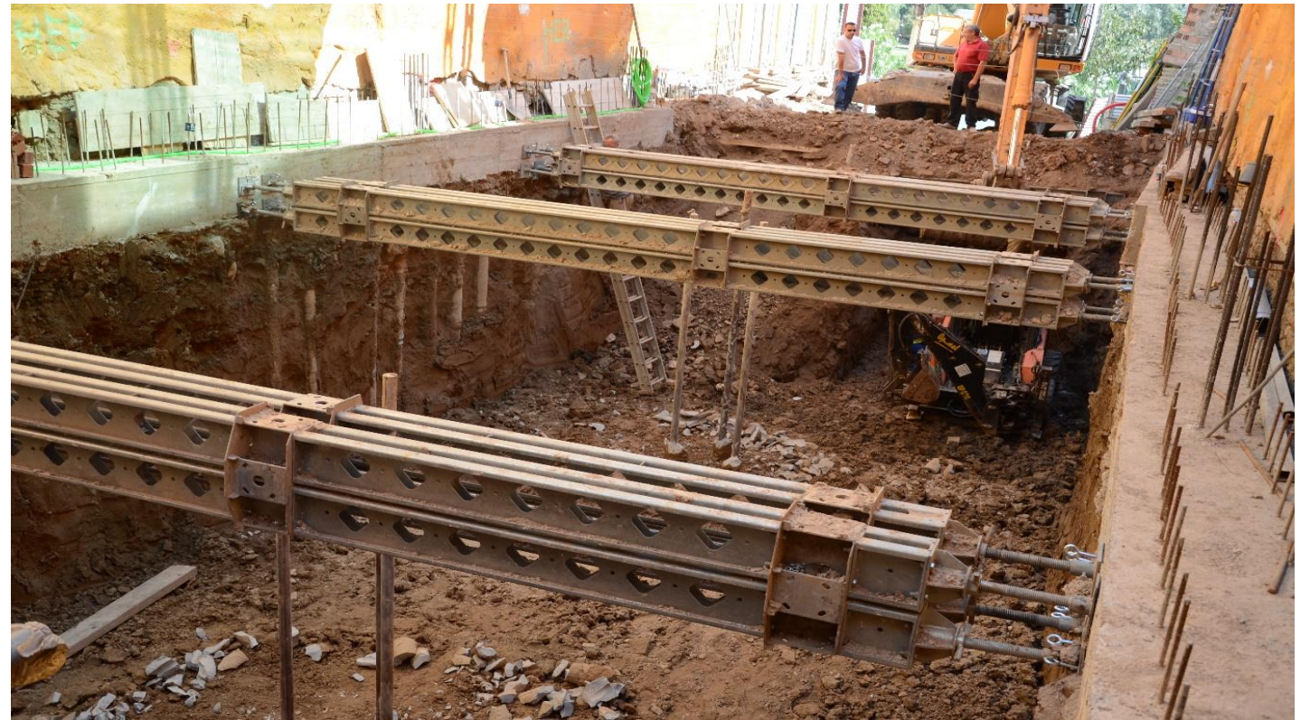
Sistema Soldier MKII, como puntales horizontales de altas cargas para el apuntalamiento de muros pantalla de un sótano
