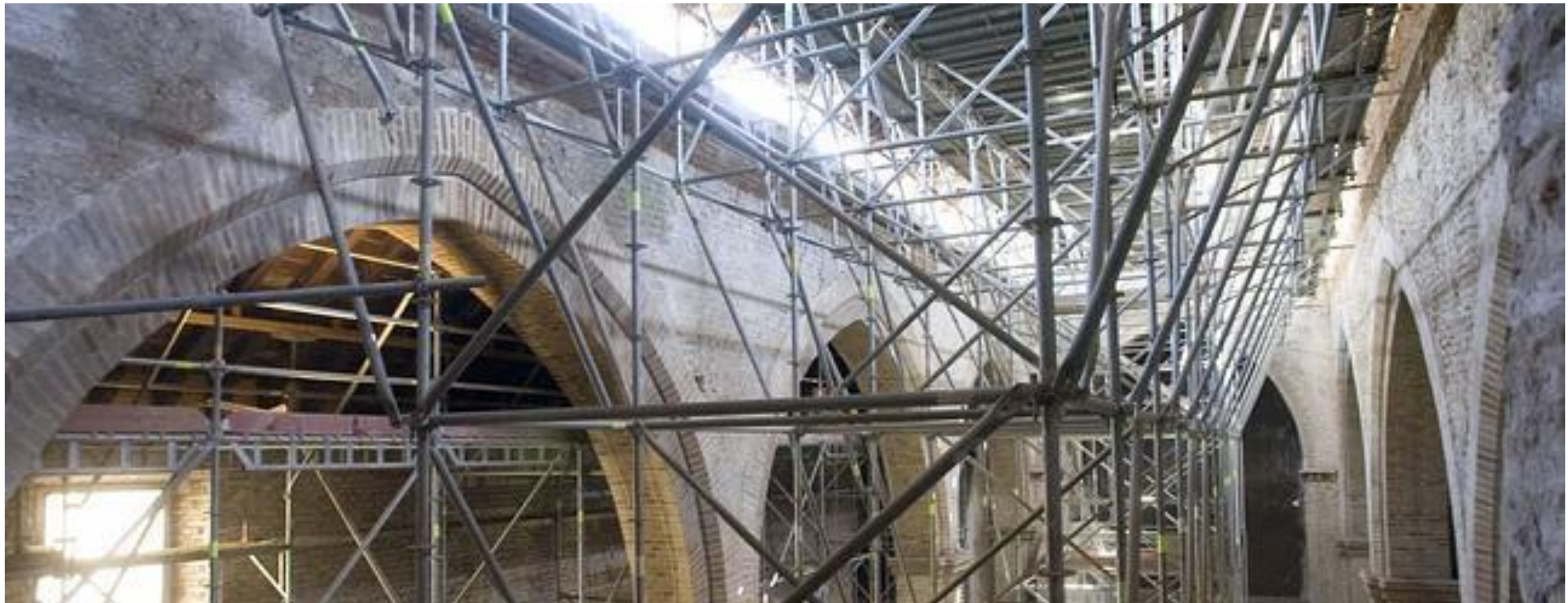
Apuntalamiento de arcos en la Iglesia de Santa Catalina de Sevilla.
