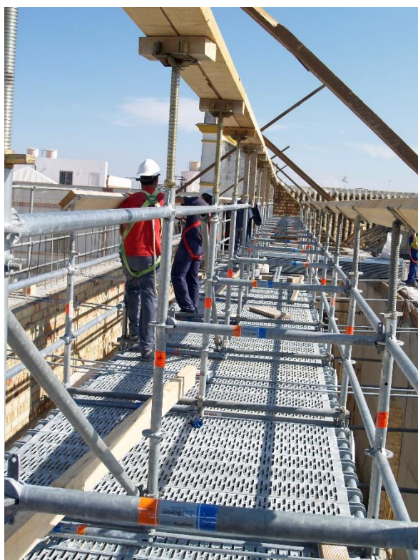
Apuntalamiento para una cubierta a dos aguas en la rehabilitación del antiguo Hospital de San Jerónimo (Marchena).
