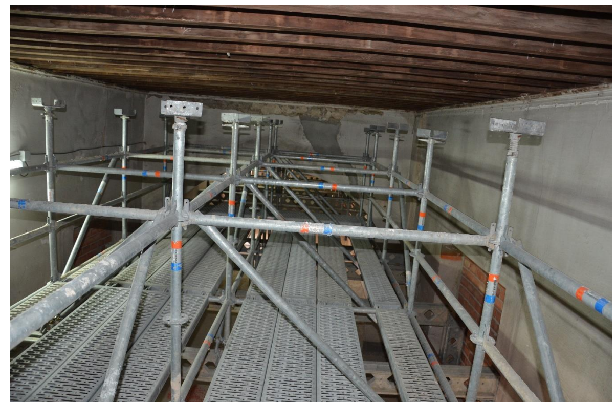
Apuntalamiento de arcos en el Palacio Conde de Torrejón de Sevilla.
