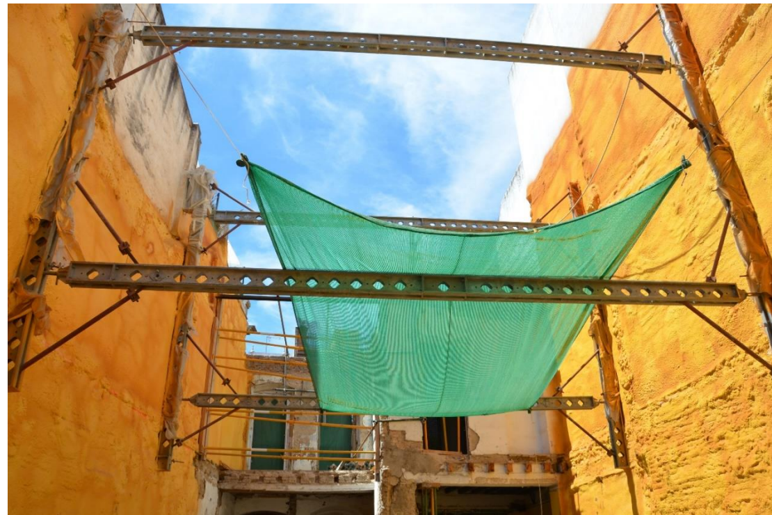
Sistema Soldier MKII, como puntales horizontales de altas cargas para el apuntalamiento de muros medianeros.
