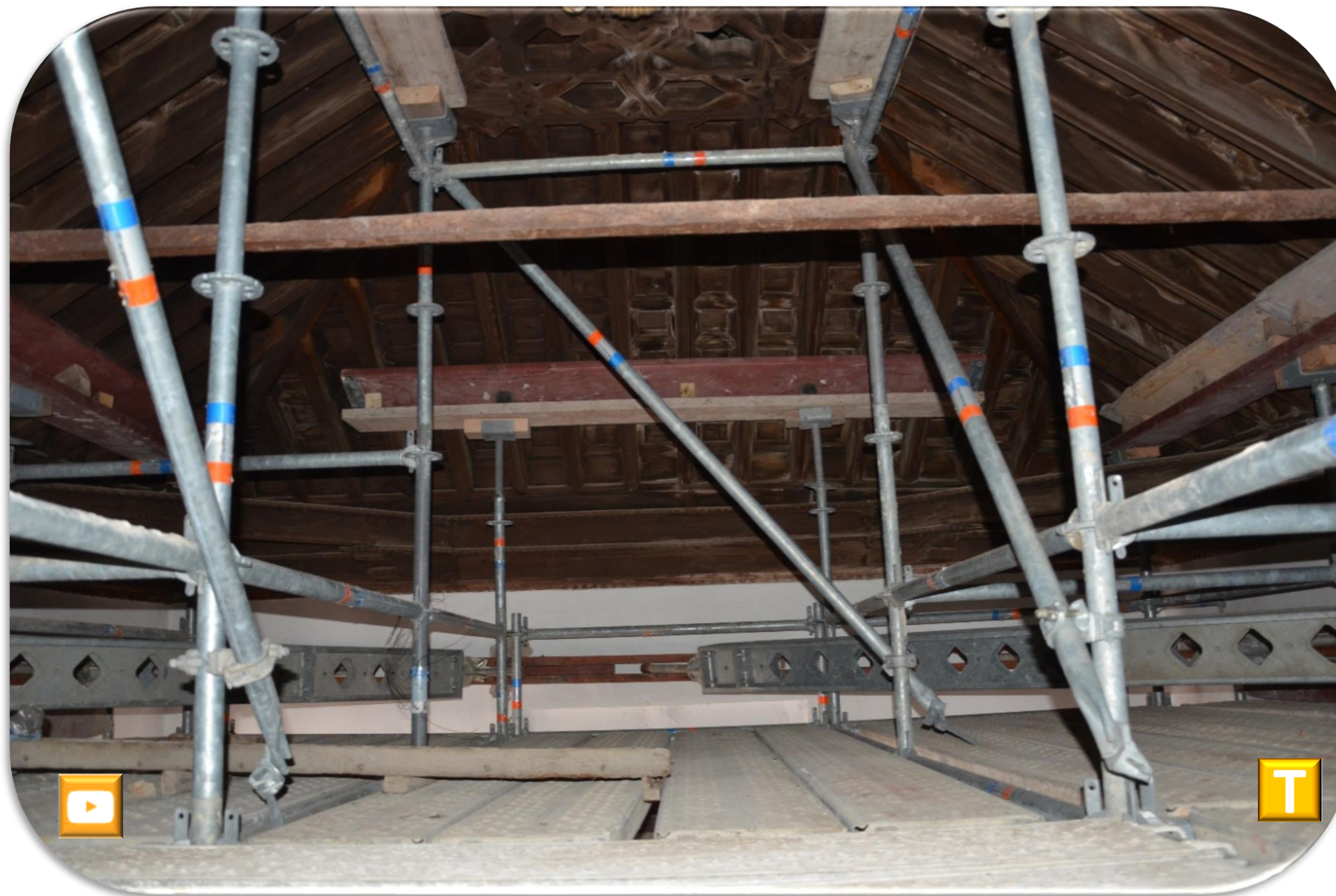
Rehabilitación del Palacio de los Condes de Torrejón (Sevilla)
