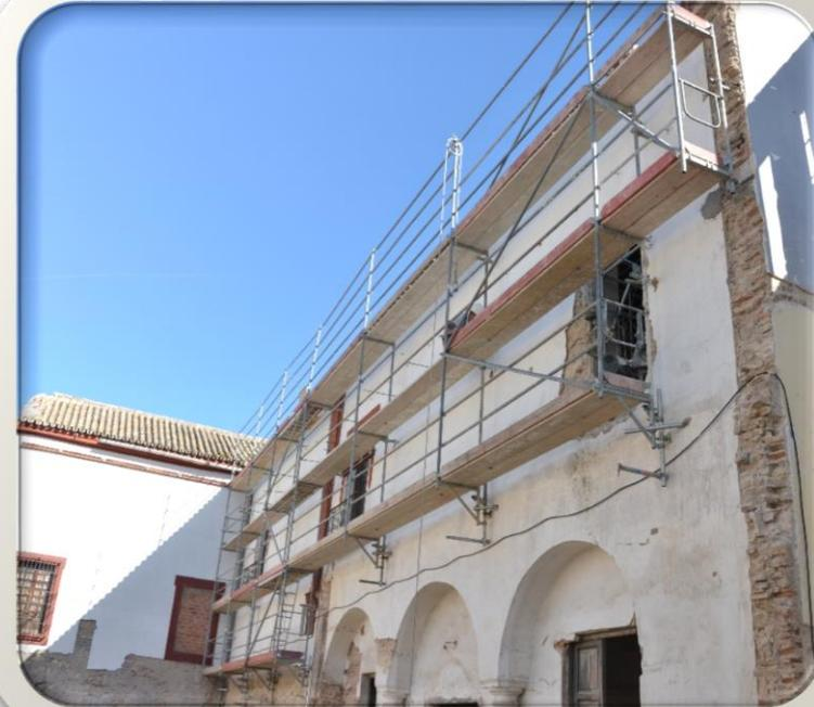
En este patio se tenía que escavar un sótano, pero los trabajos en cubierta que se tenían que desarrollar nos obligan a montar un andamio suspendido de los paramentos. El arreglo de cubiertas sin interferir el acceso al edificio nos lleva a montar un andamio volado desde el interior.
