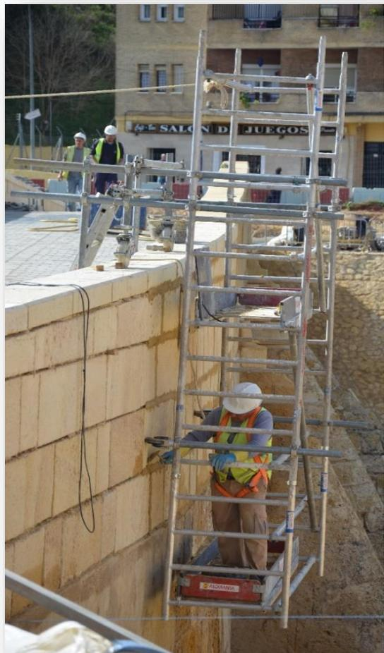
En el Puente de Carlos III de Alcalá de Guadaíra se montan estos andamios partiendo de unos tajamares con una gran inclinación, el uso de vigas de celosías corridas a lo largo del puente nos permite por un lado volar el andamio y por otro suspenderlo, las intensas lluvias de aquel año recomendaba dar soluciones en caso de crecidas que posibilitaran un rápido desmontaje del tramo de descuelgue.
