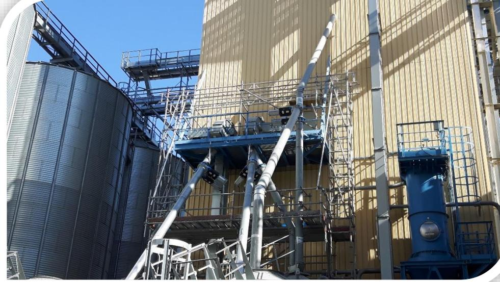
Las dificultades para arrancar con un andamio desde el suelo por la disposición de depósitos y conductos nos llevan a montar un andamio volado y descolgado desde una plataforma. Para cubrir el perímetro de unos condensadores evaporativos se monta un andamio que parten de un paramento situado sobre una cubierta de panel sándwich, las fijaciones y anclajes evitan el apoyo en dicha cubierta.
