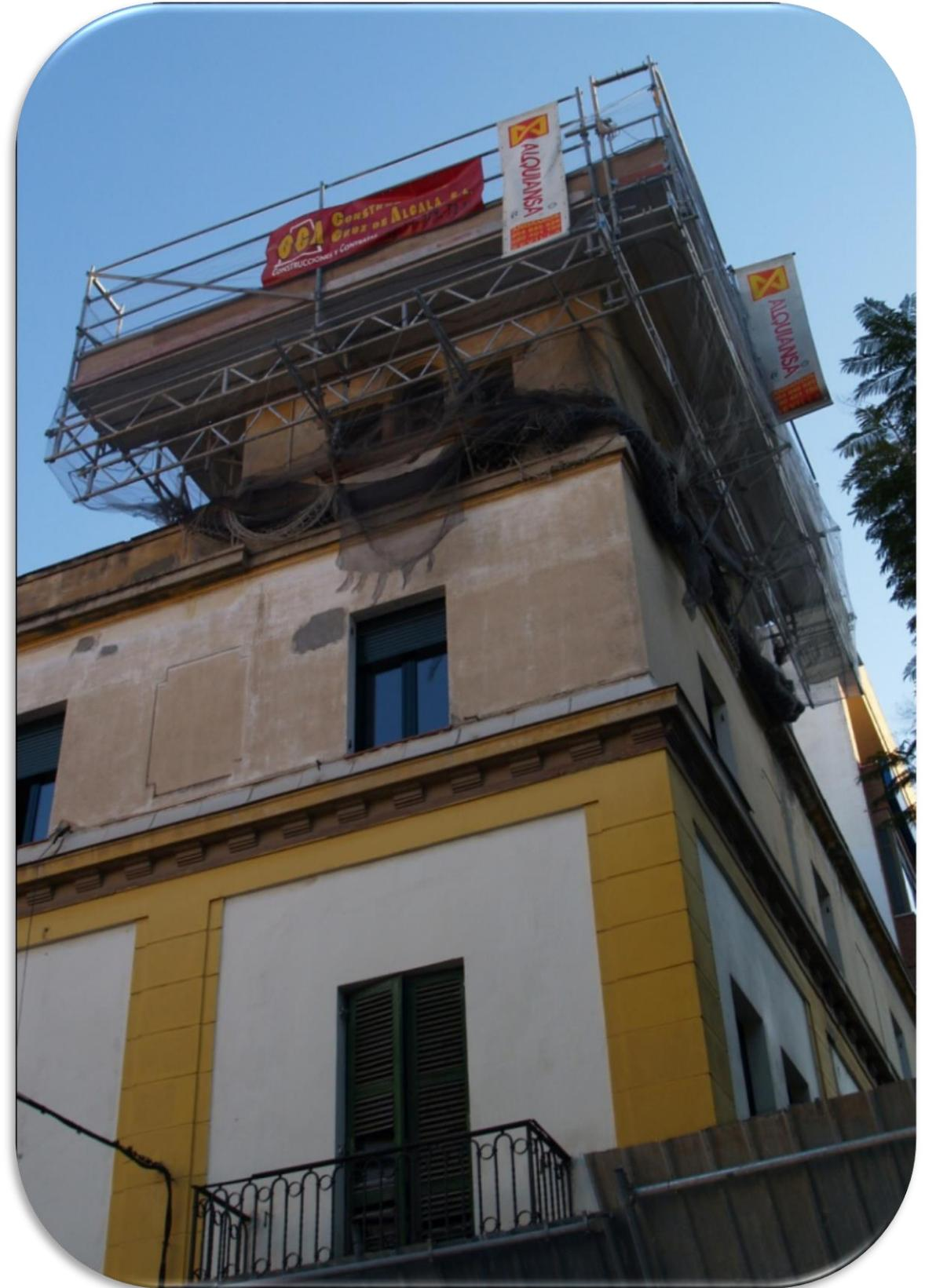
En la torre de control del Puente de Carranza en Cádiz y desde este torreón en Sevilla el andamio parte suspendido desde una estructura que se monta en el interior.
