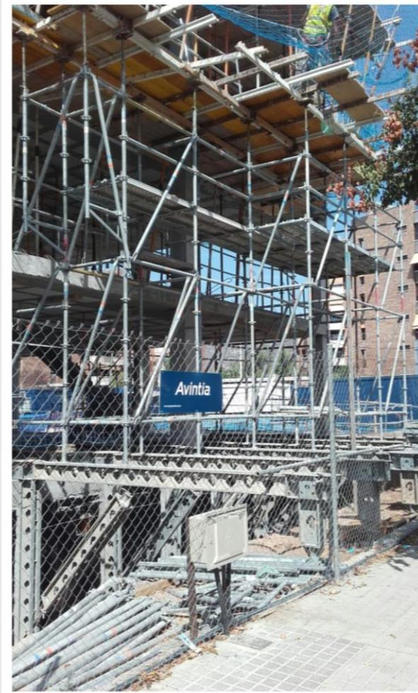
El uso combinado de la estructura Soldier para la estabilización de fachadas con el andamio multidireccional nos permite suspender los andamios para el apuntalamiento de losas en lugares donde el terreno es inestable o los forjados no tienen capacidad de carga.
