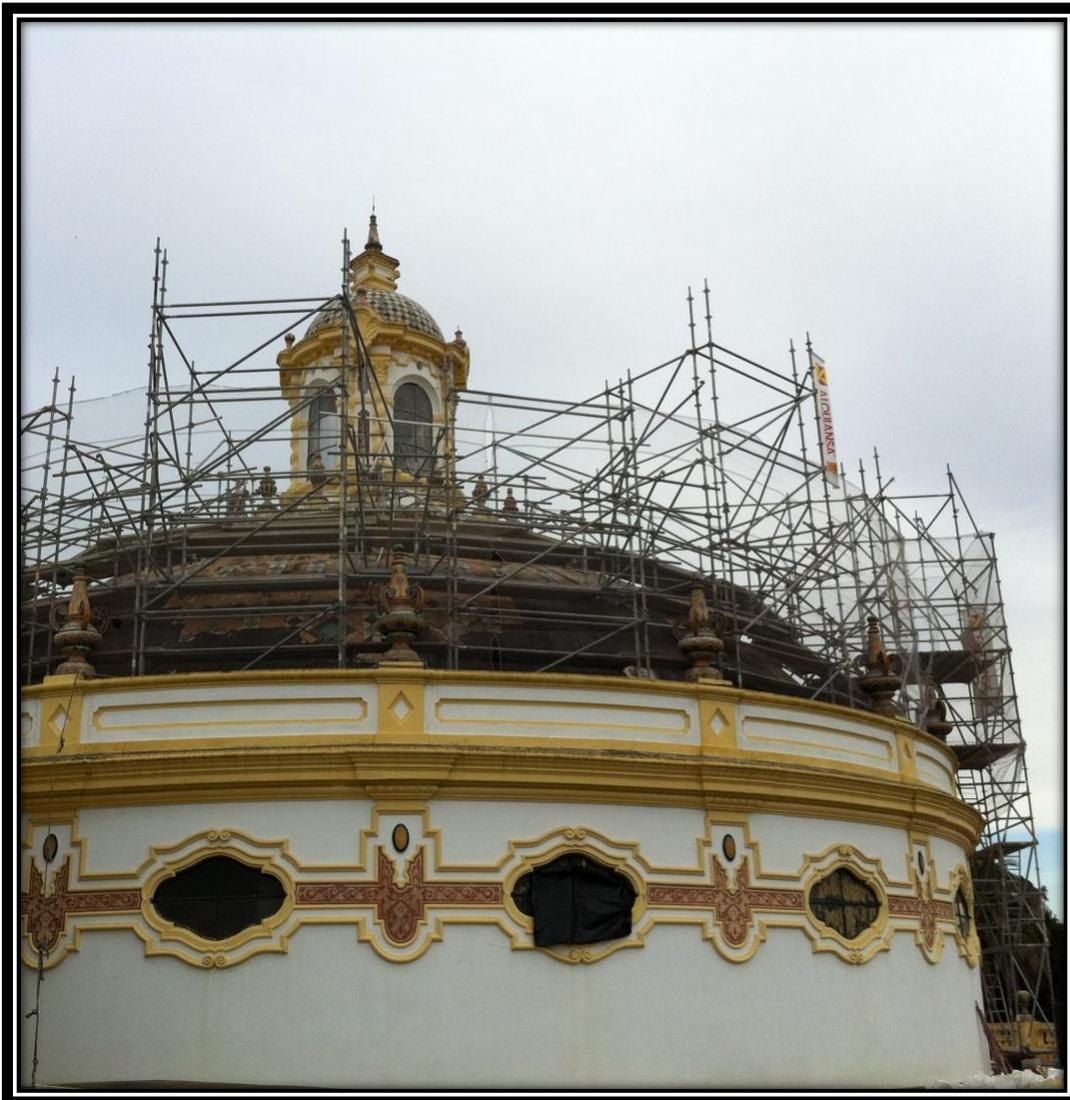
En la cubierta del Casino de la Exposición de Sevilla era necesario retirar el recubrimiento cerámico y la posterior impermeabilización y reposición, no era posible apoyar en ningún punto solo en el estrecho pasillo perimetral y en el entorno de la linterna el resto del andamio quedará suspendido.
