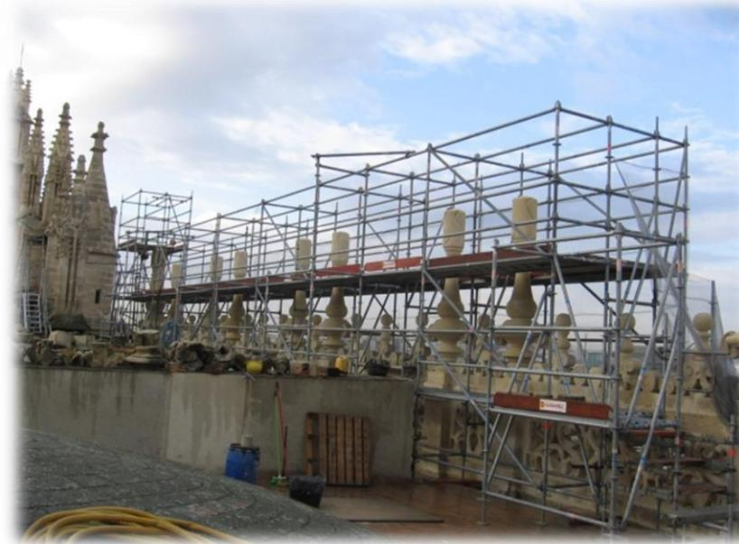
Desde el interior de las cubiertas o del campanario se crean estructuras que permiten volar al exterior estos andamios destinados a la restauración de la crestería y flameros del Sagrario y una cara de la Giralda de Sevilla.
