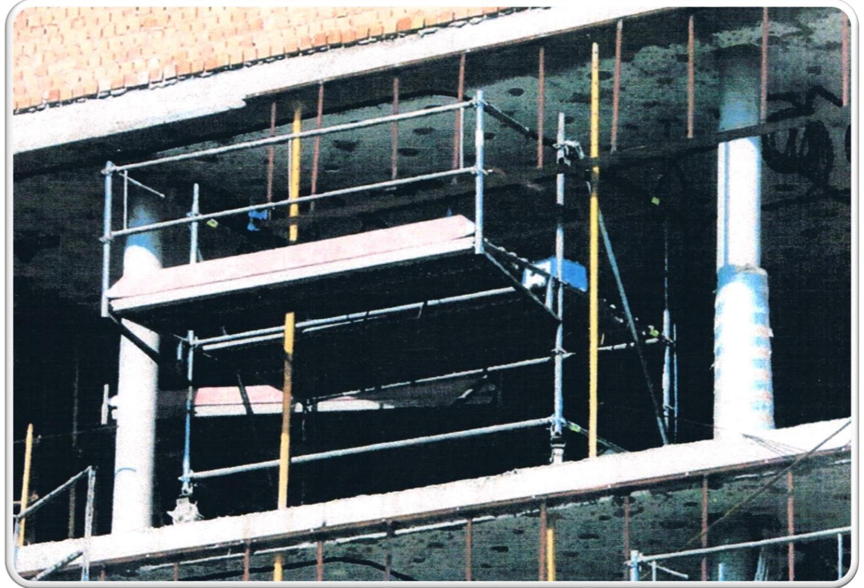
Estructuras con ruedas y apuntaladas permiten en esta ocasión el arreglo de la cubierta de un edificio y el labrado de unos petos que descuelgan del forjado superior, como solución es ideal pues con un módulo que se va desplazando se consigue cubrir una amplia superficie, la afectación en obra es mínima y la cantidad de materiales a utilizar muy pequeña.
