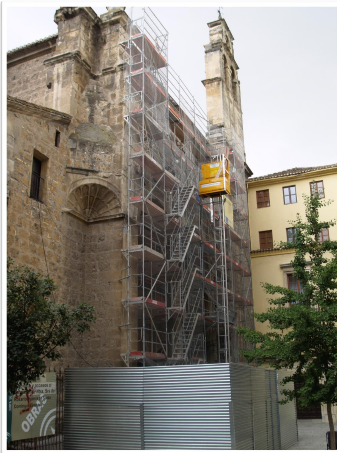
Puerta y fachada de la Ig. de Santo Domingo en Granada.
