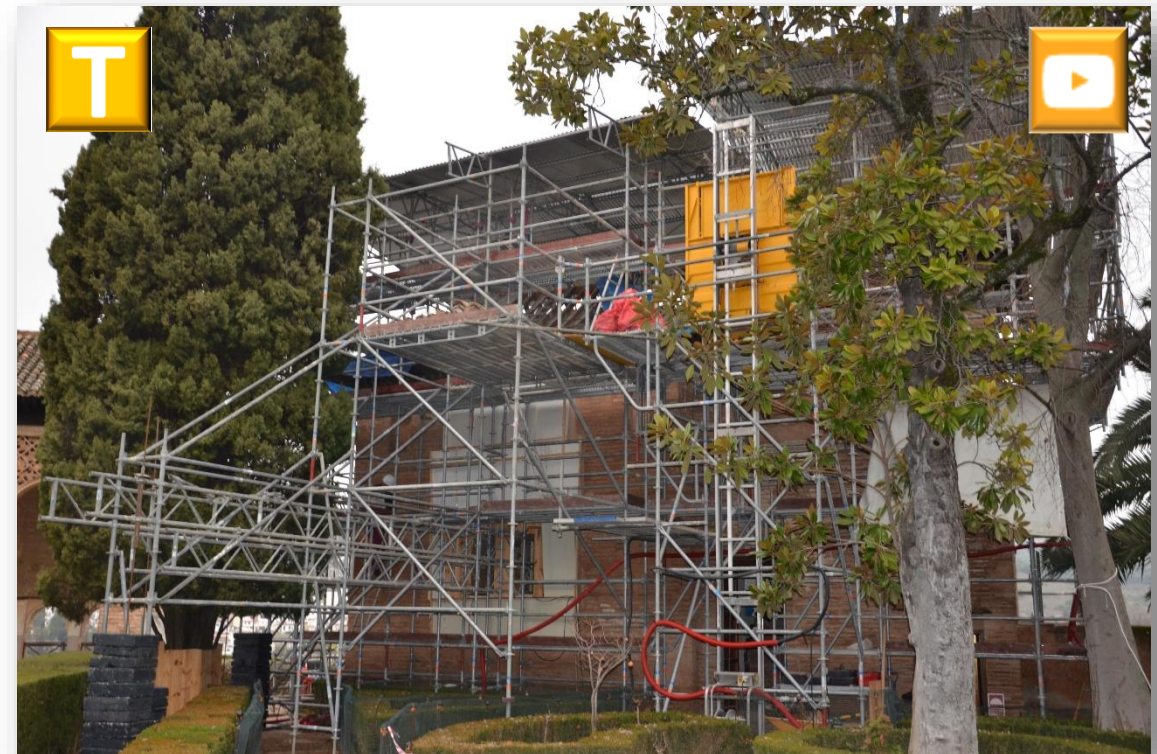
Restauración Oratorio del Partal La Alhambra (Granada).
