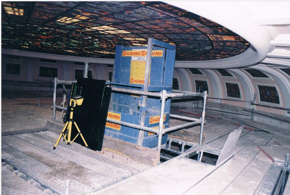
Restauración vidriera del Teatro de la Plaza de España
