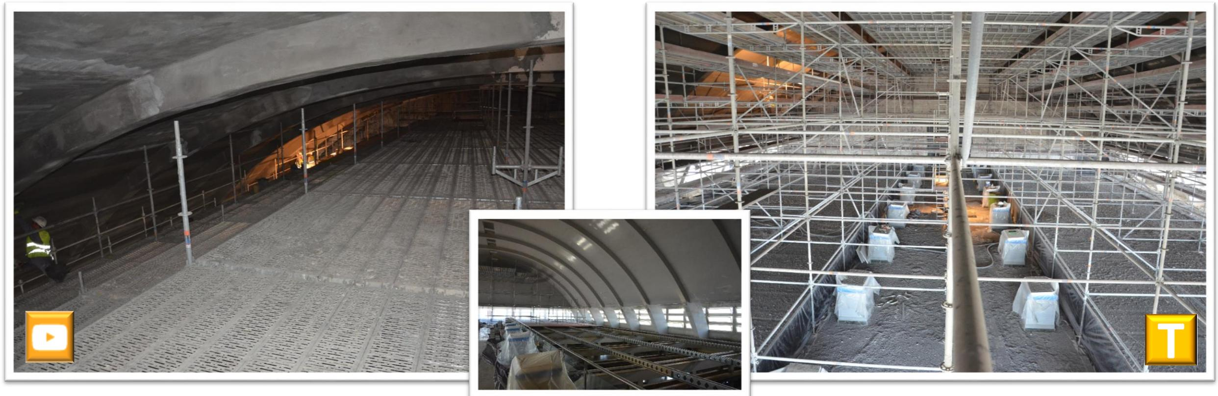
Andamio para la rehabilitación interior de la cubierta semicilíndrica de la Depuradora de Villa Azul (Córdoba) librando las piscinas de filtro. Andamio para el aislamiento de un depósito de precipitación partiendo con vigas Soldier MkII .
