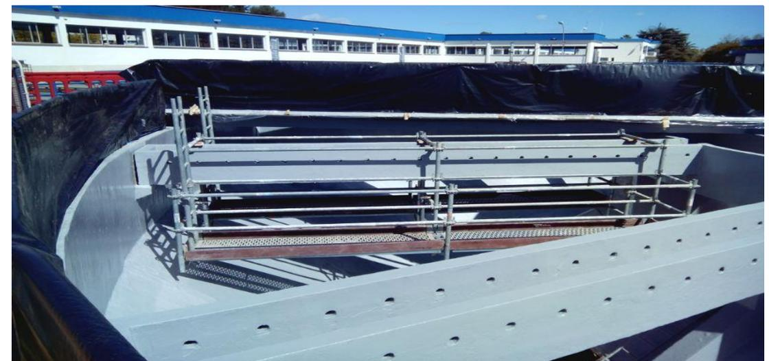
Andamio suspendido - reparación canales depuradora
