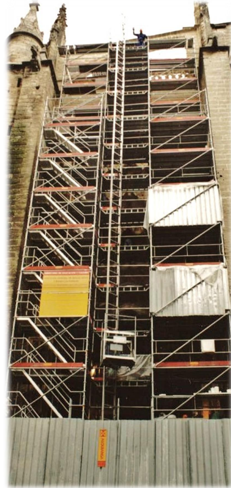
Restauración de la Puerta del Bautismo.
