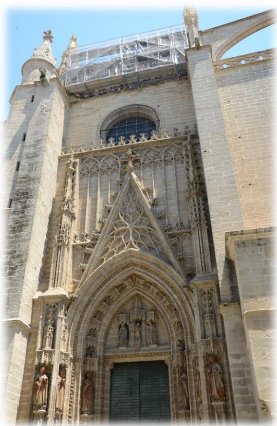
Andamios descolgados sobre las puertas del Bautismo y del Nacimiento para el trabajos en los arbotantes.
