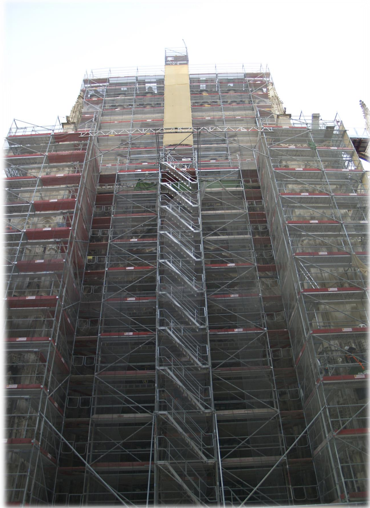
Restauración de la Puerta de la Asunción.
