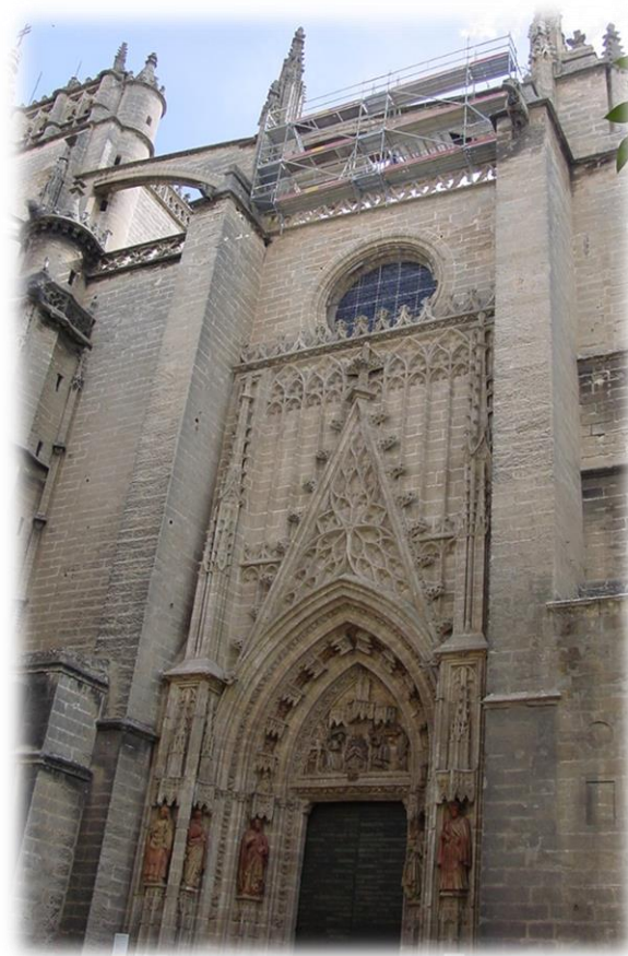
Andamios descolgados sobre las puertas del Bautismo y del Nacimiento para el trabajos en los arbotantes.
