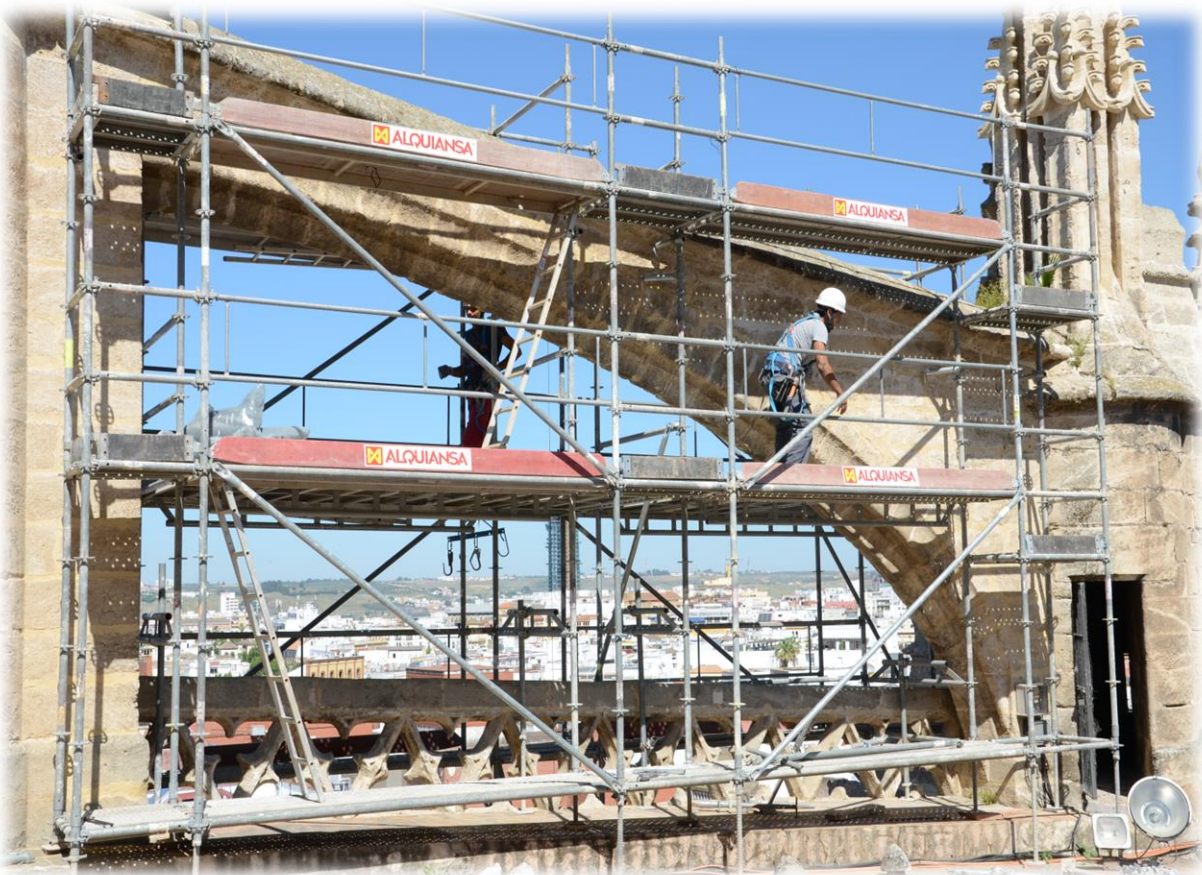
Andamios descolgados sobre las puertas del Bautismo y del Nacimiento para el trabajos en los arbotantes.
