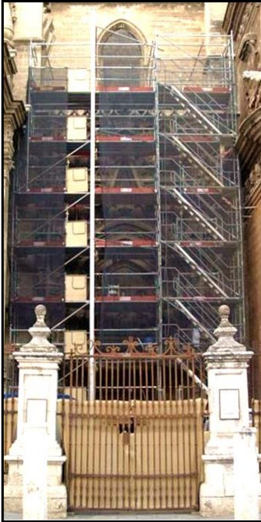
Restauración de la Puerta de Campanillas.
