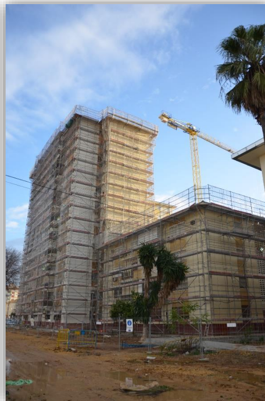
Rehabilitación integral barriada Bi-Rambla (Parque Alcosa) Sevilla. (24.800m 2 de superficie andamiada)
