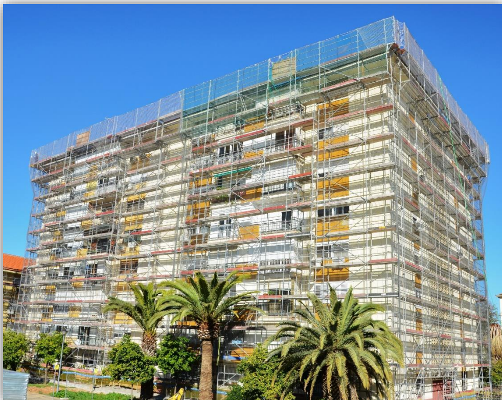
Rehabilitación integral barriada Bi-Rambla (Parque Alcosa) Sevilla. (24.800m 2 de superficie andamiada)
