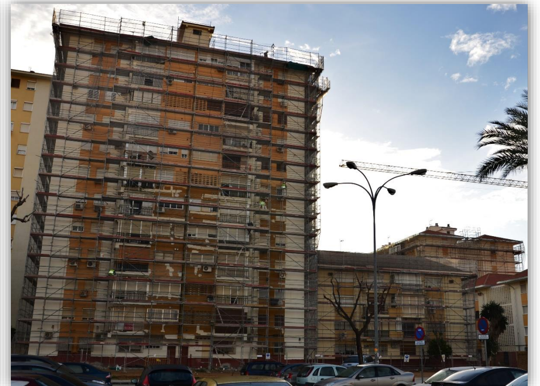
Rehabilitación integral barriada Bi-Rambla (Parque Alcosa) Sevilla. (24.800m 2 de superficie andamiada)
