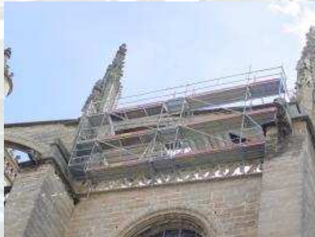
Andamio volado en Catedral de Sevilla
