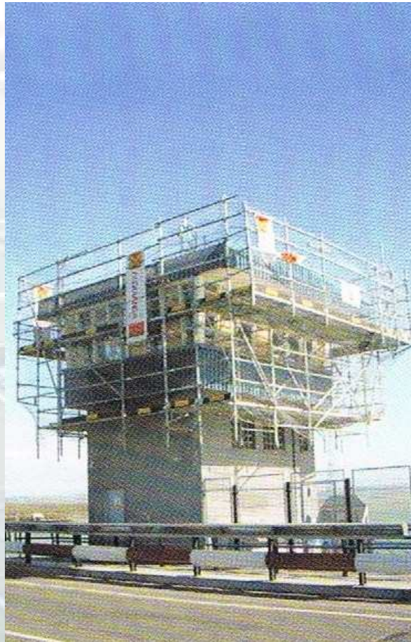
Andamios volados desde estructuras en interior del edificio
