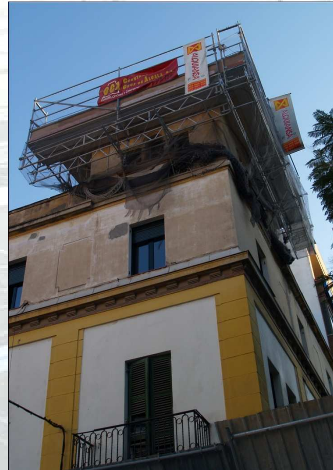
Andamios volados desde estructuras en interior del edificio
