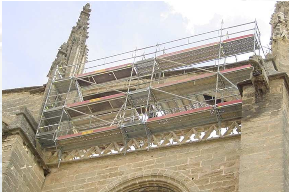
Andamio volado al exterior para trabajos en arbotante de catedral.
