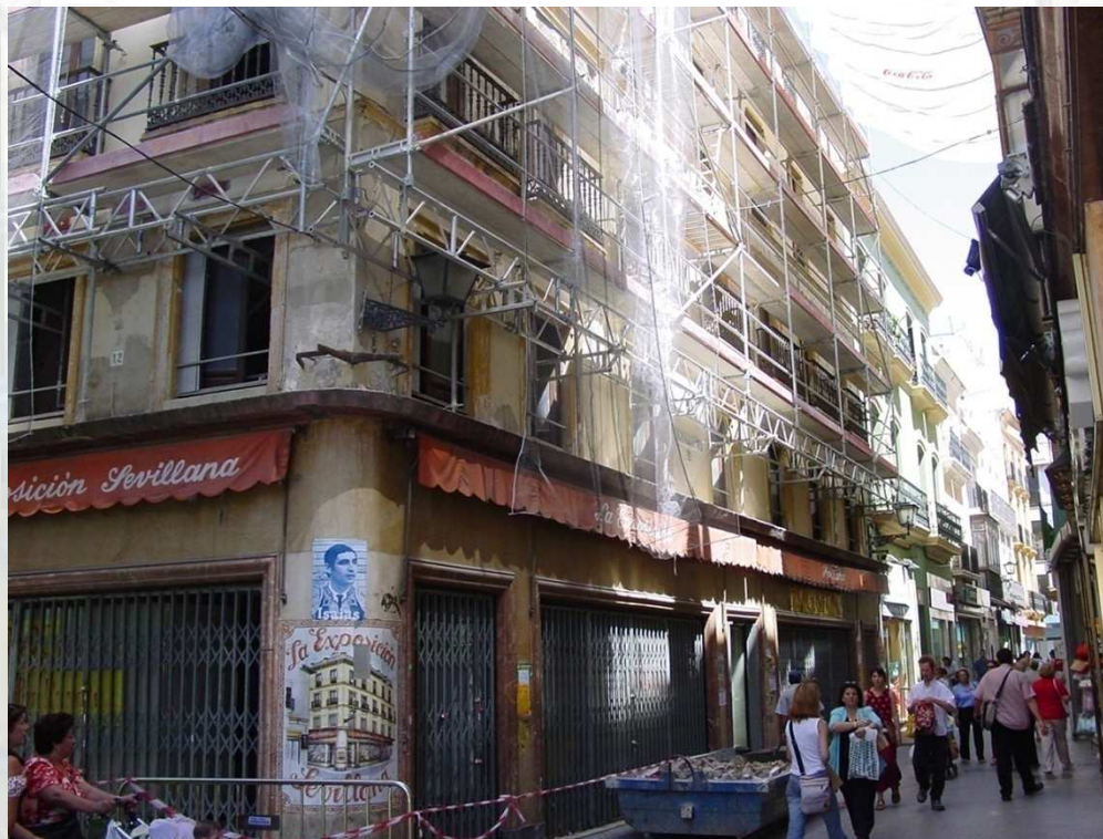
Andamios volados desde estructuras en interior del edificio
