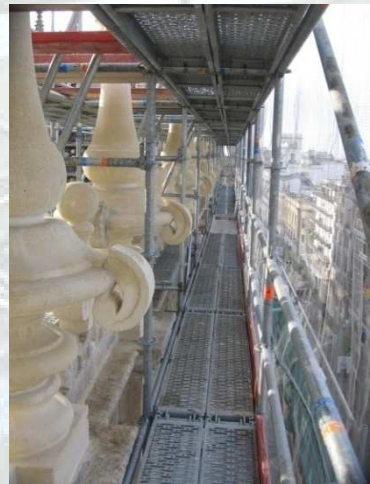
Restauración de crestería con andamio interior y exterior
