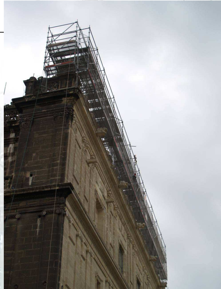
Restauración de crestería con andamio interior y exterior
