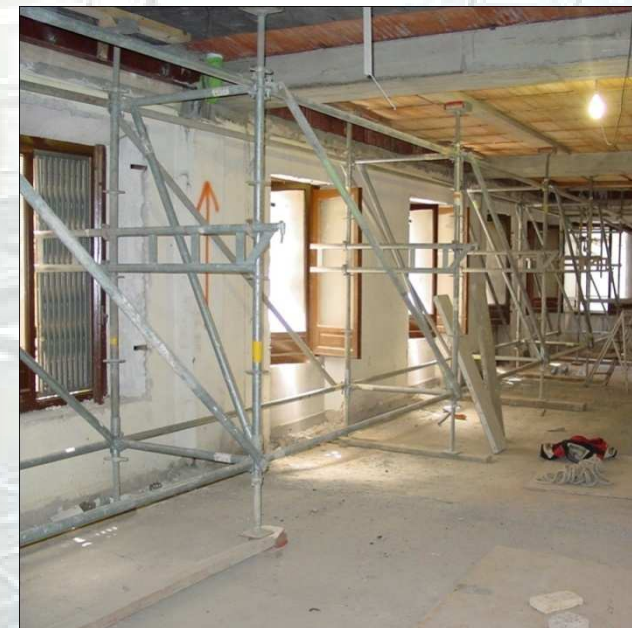
Detalle de estructura interior apuntalada entre plantas
