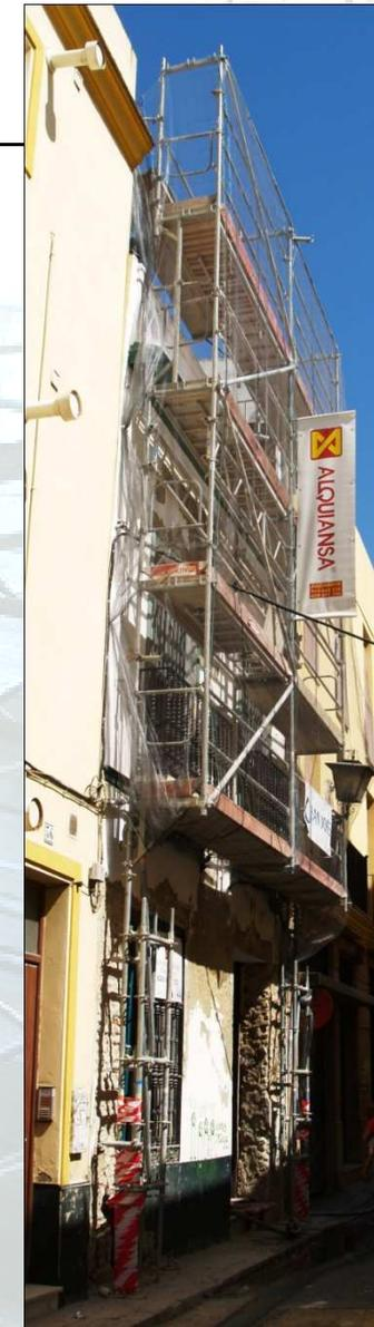
Andamio partiendo con pies estrechos en los laterales y el pié central volado para abrir puerta de 4m. De ancho, en la fachada.
