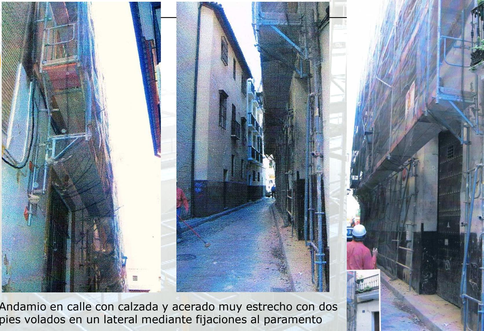
Andamio en calle con calzada y acerado muy estrecho con dos pies volados en un lateral mediante fijaciones al paramento
