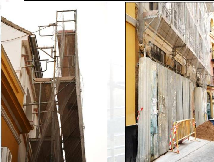
Andamio sobre pies estrechos con cerramiento de chapa en el arranque del mismo para evitar el acceso y vuelo al exterior con ménsulas para la creación de la protección del tejador.
