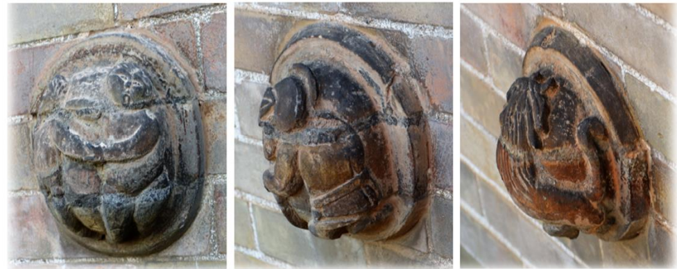
Bolas de la Casa de las Conchas, mediante la técnica del ladrillo tallado.
