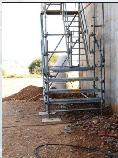
Depósitos de agua Montequinto. Escalera para acceso a cubierta del depósito con detalles del arranque y desembarco de la misma.
