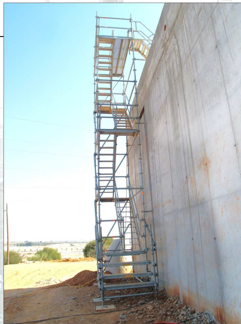
Depósitos de agua Montequinto. Escalera para acceso a cubierta del depósito con detalles del arranque y desembarco de la misma.
