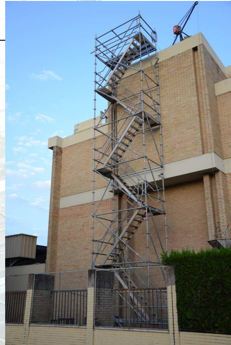
Colegio Santo Ángel (Sevilla) Escalera de acceso a la cubierta del salón de actos y detalle del primer tramo para adaptación de altura.
