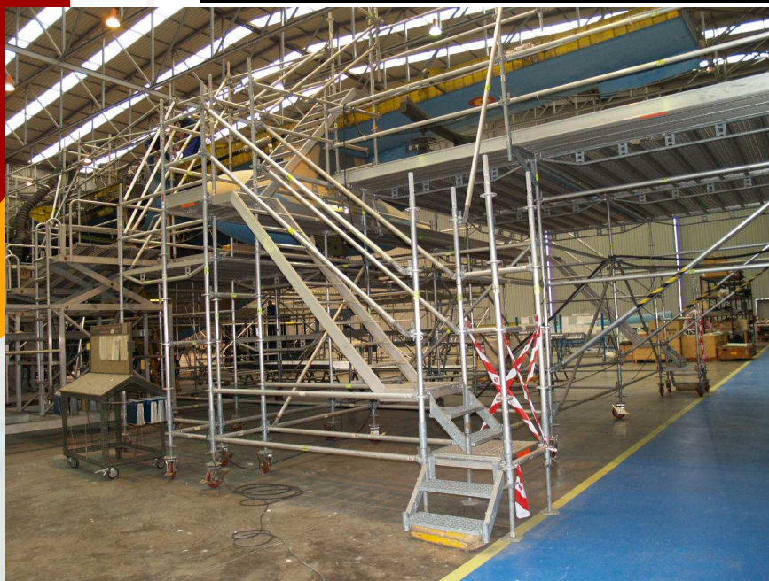
Escaleras para acceso a plataformas de trabajo en la reparación de aviones.
