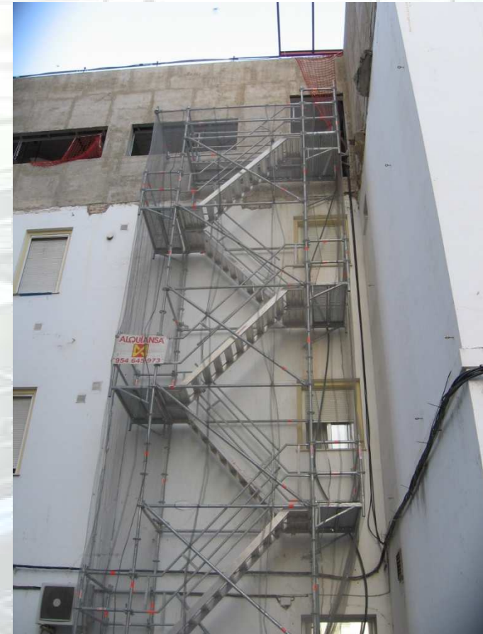
Escalera de acceso con desembarcos laterales.
