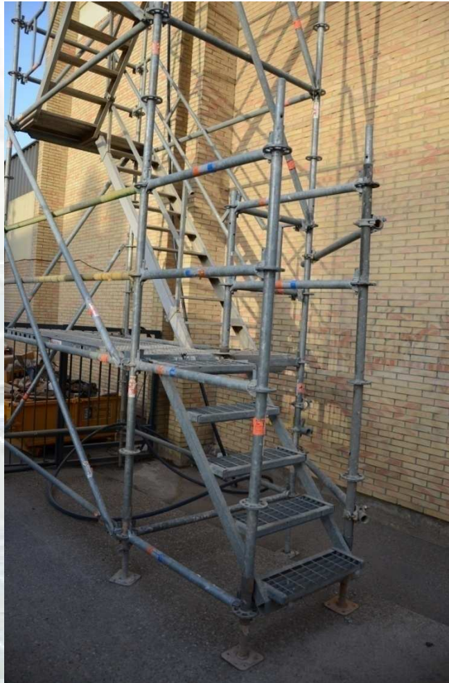
Colegio Santo Ángel (Sevilla) Escalera de acceso a la cubierta del salón de actos y detalle del primer tramo para adaptación de altura.
