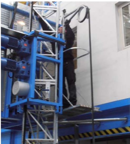
PLATAFORMA AUXILIAR PARA MONTAJE DE ANCLAJES
