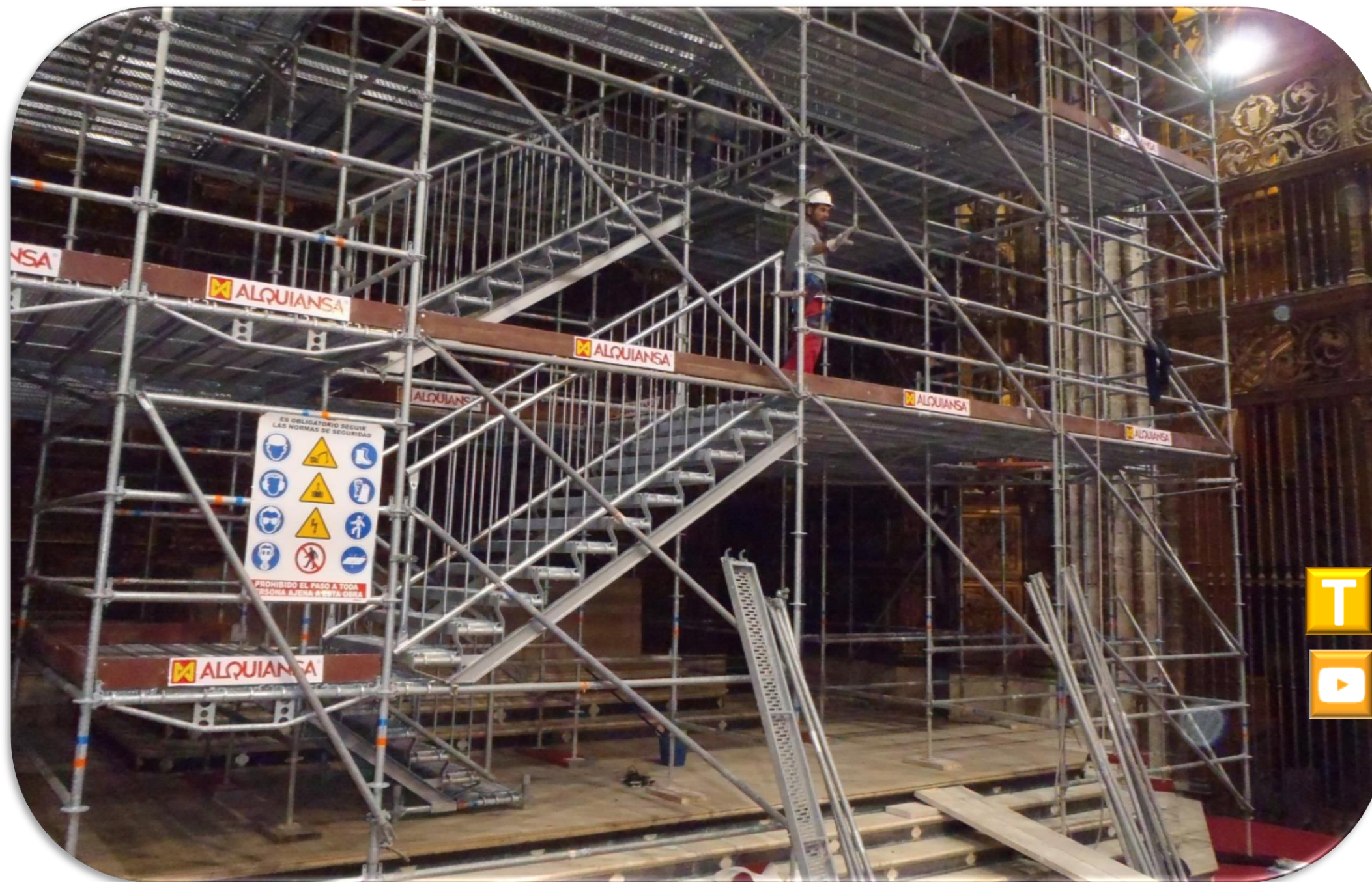
Escalera de acceso al andamio para la restauración del Retablo Mayor de la Catedral de Sevilla.
