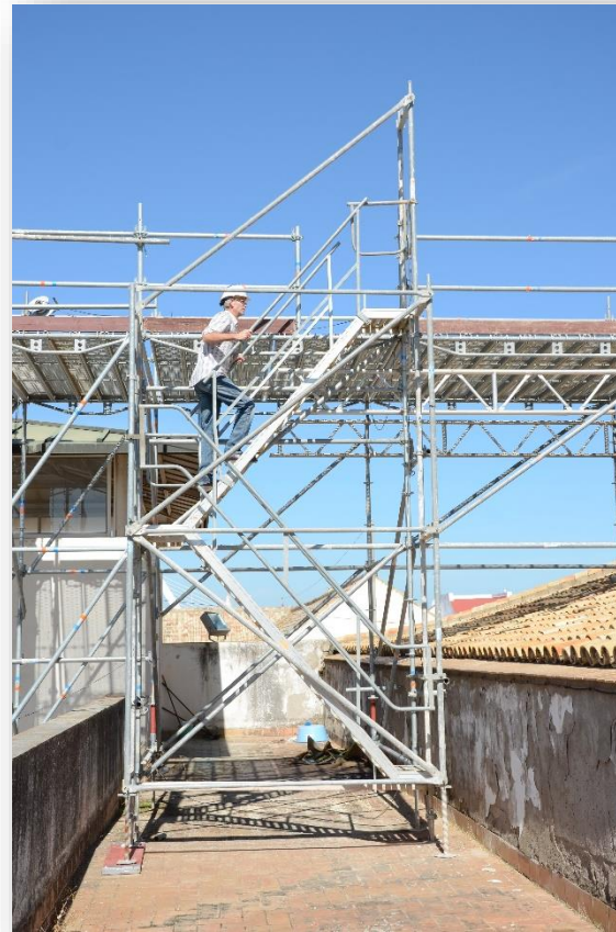
Escalera de acceso con plataformas con trampilla y con escaleras adosadas o en Zig-Zag.
