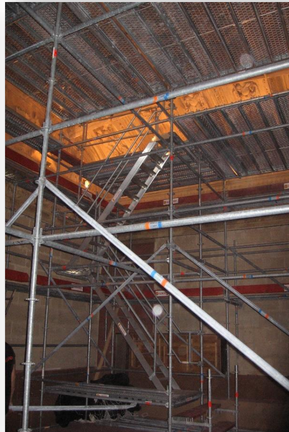
Escalera de acceso con plataformas con trampilla y con escaleras adosadas o en Zig-Zag.
