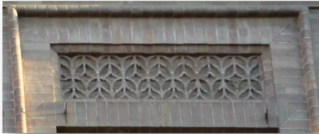
Paramentos sobre puertas de balcones de la 2ª planta.
