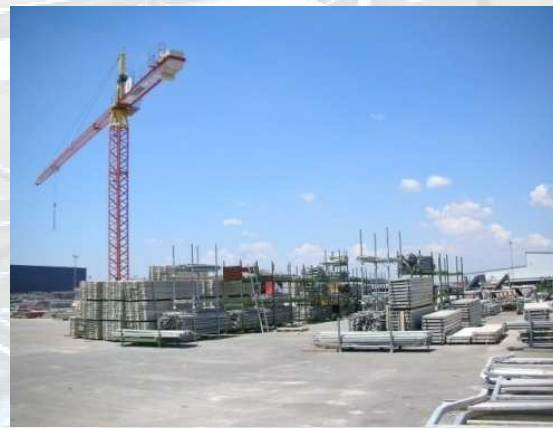
CAMPA DE ALMACENAJE
