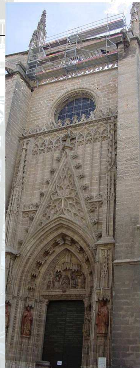
Restauración de arbotante en la Puerta de San Miguel de la Catedral de Sevilla (Andamio volado para dejar libre la entrada )
