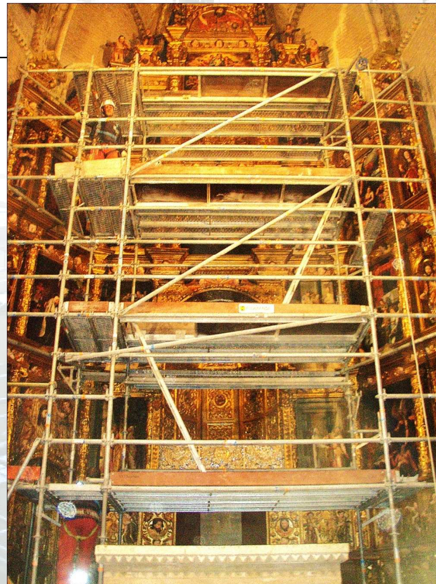
Restauración del Retablo de la Iglesia de Sta. Ana.-Triana(Sevilla) Pedro de Campaña (1557) Proceso desmontaje del andamio.
