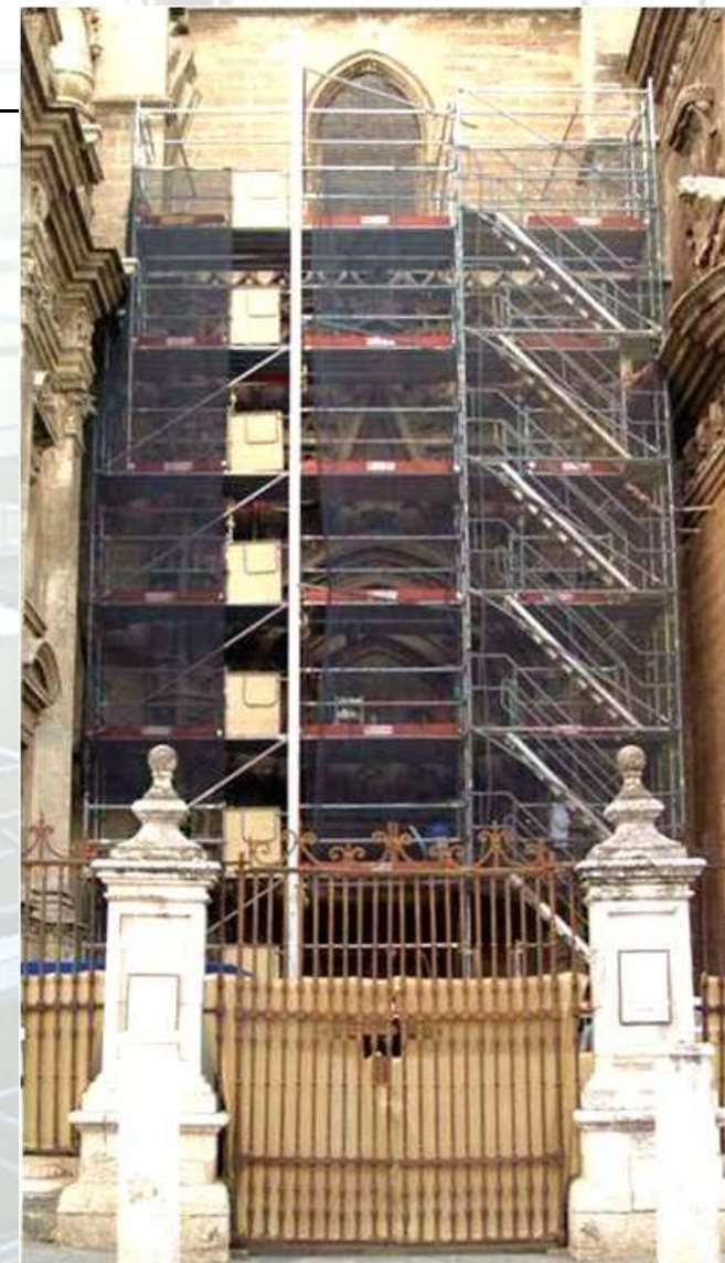
Portada de Campanillas Catedral de Sevilla. Andamio con montacargas y escaleras de acceso.
