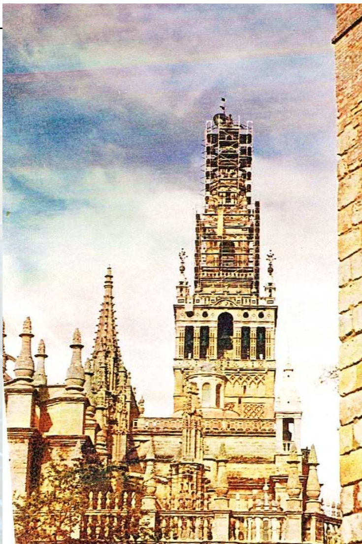
Giraldillo: 1ª Intervención (Estudio estado del Giraldillo)
