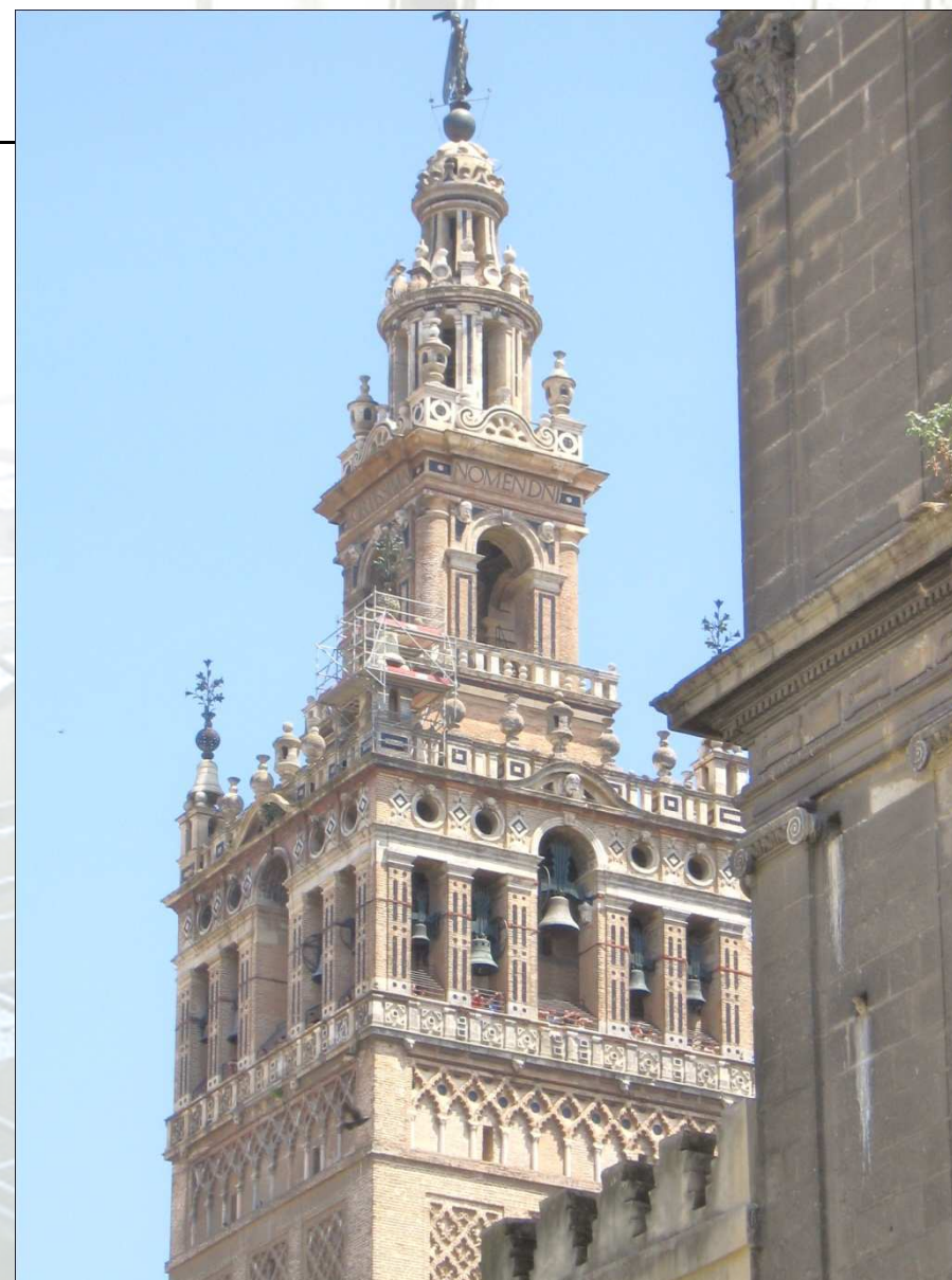
Restauración Azucenas (Giralda cuerpo de Azucenas) Andamio volado al exterior.
