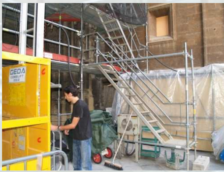
Portada de Campanillas Catedral de Sevilla. Andamio con montacargas y escaleras de acceso.
