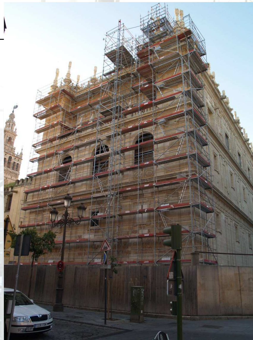
Fachada Sagrario a c/Alemanes. Montacargas adaptado a estructura para acceso a cubierta Andamio en Fachada para restauración de la misma.
