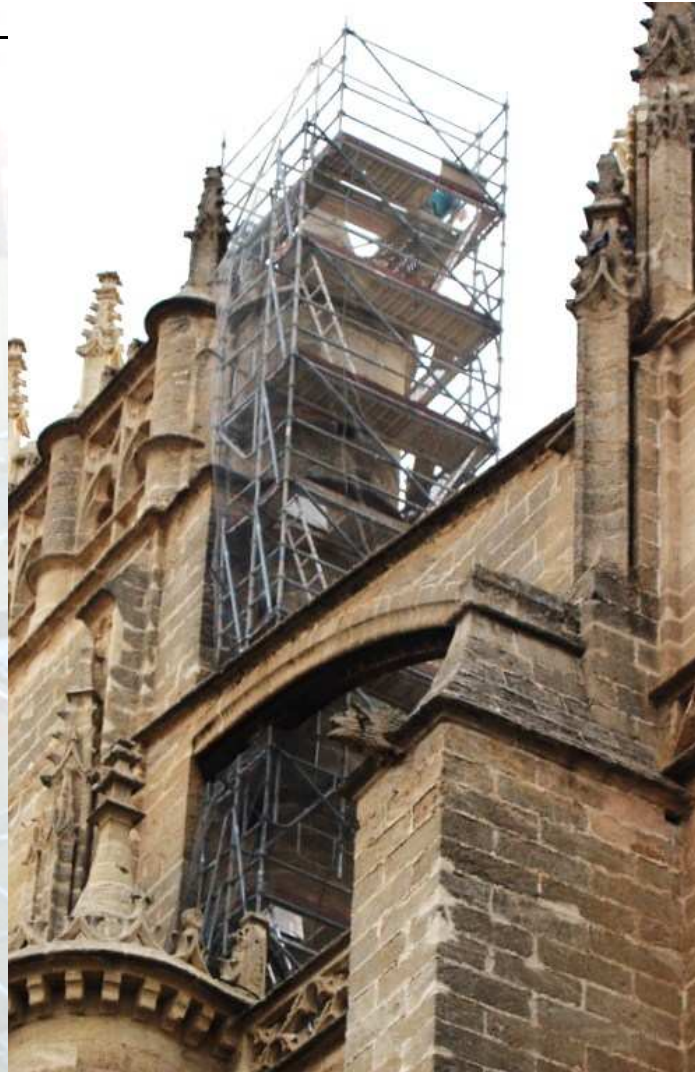
Escalera de acceso a cubierta nave central Puerta de la Asunción (Andamio que parte de cubierta de nave lateral librando contrafuerte)
