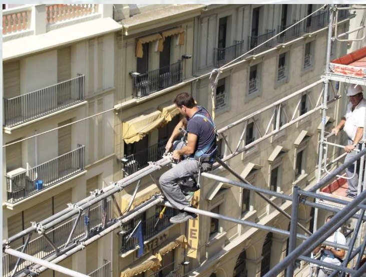
Adaptación del andamio para colocación de lona durante las obras de restauración de la fachada de la Avda. de la Constitución.
