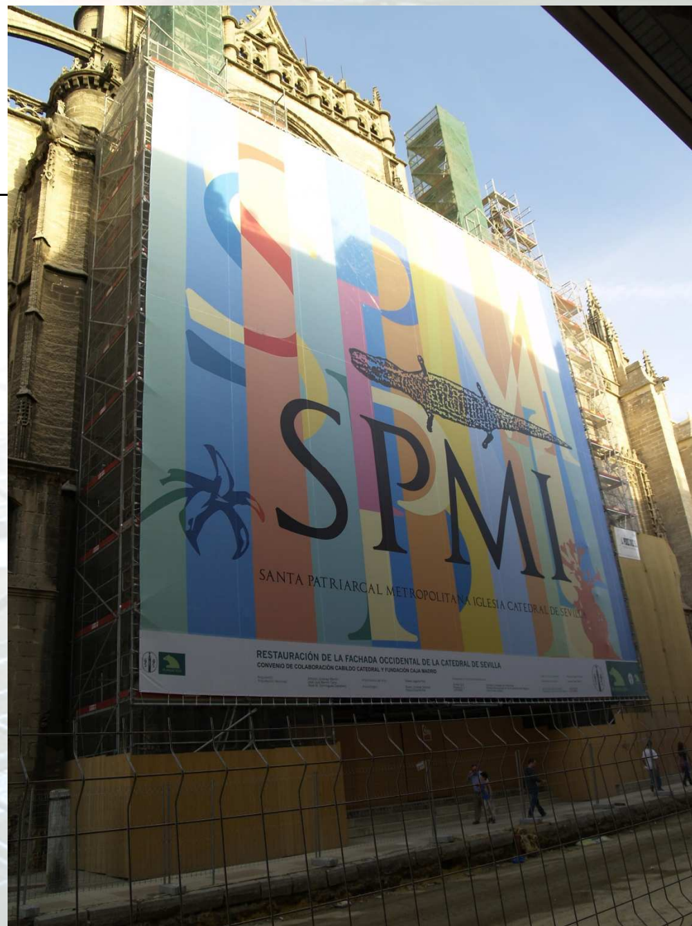
Adaptación del andamio para colocación de lona durante las obras de restauración de la fachada de la Avda. de la Constitución.
