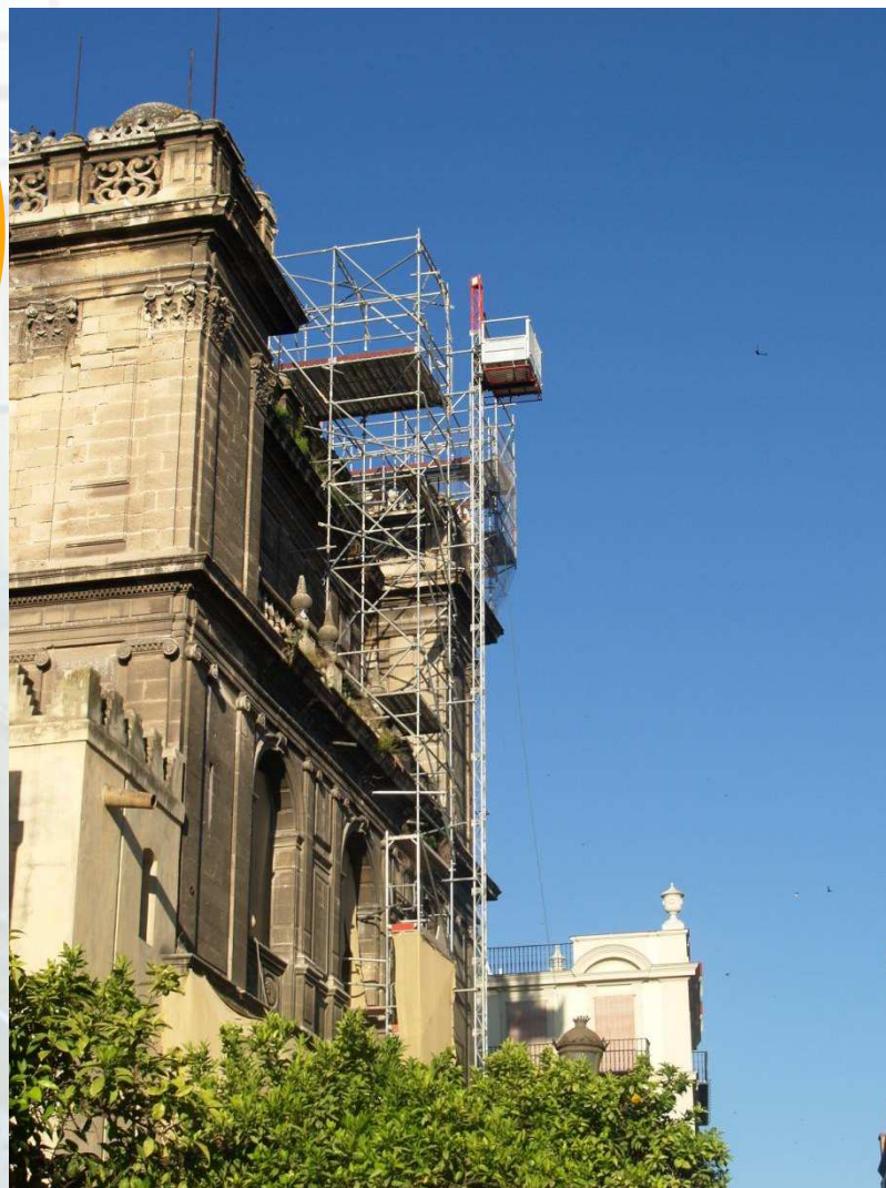
Fachada Sagrario a c/Alemanes. Montacargas adaptado a estructura para acceso a cubierta Andamio en Fachada para restauración de la misma.
