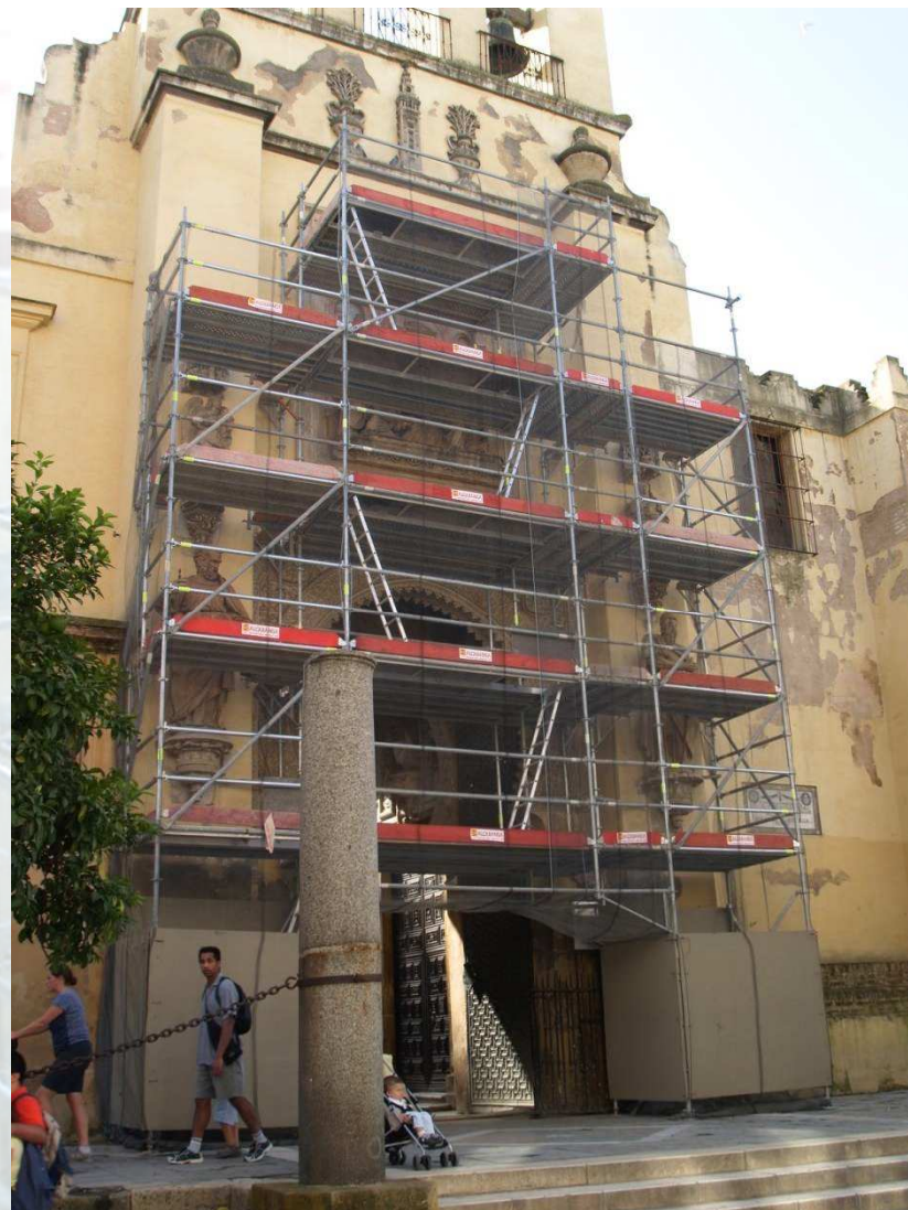
Restauración Puerta del Perdón
