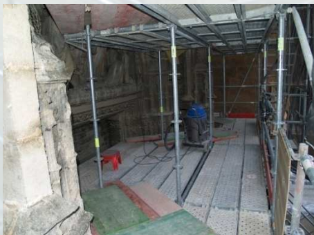
Portada de Campanillas Catedral de Sevilla. Andamio con montacargas y escaleras de acceso.
