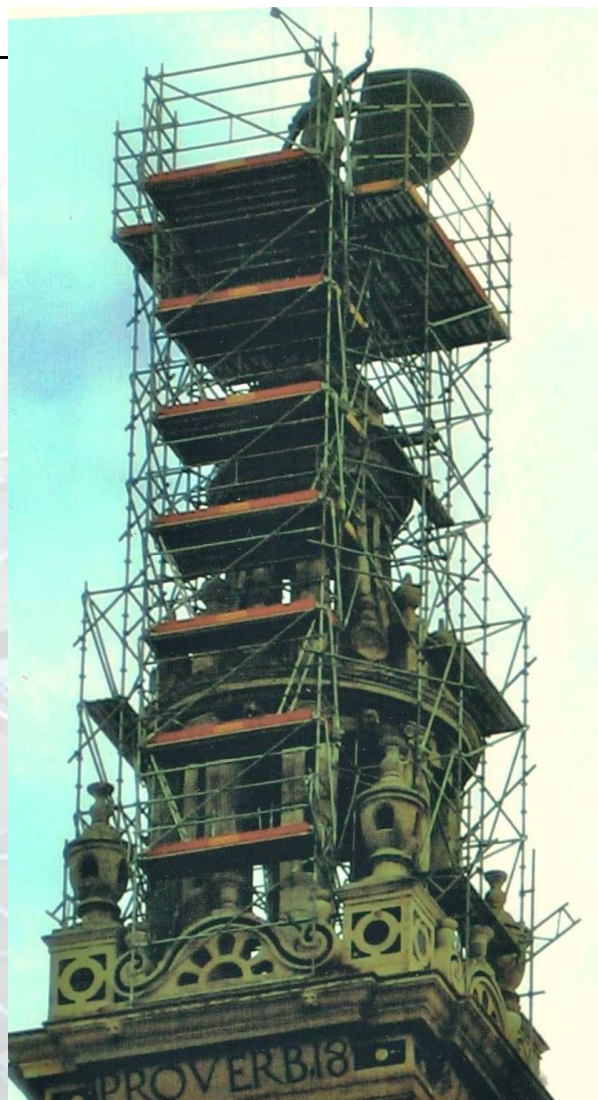
Giraldillo: 3ª Intervención(Colocación del original)
