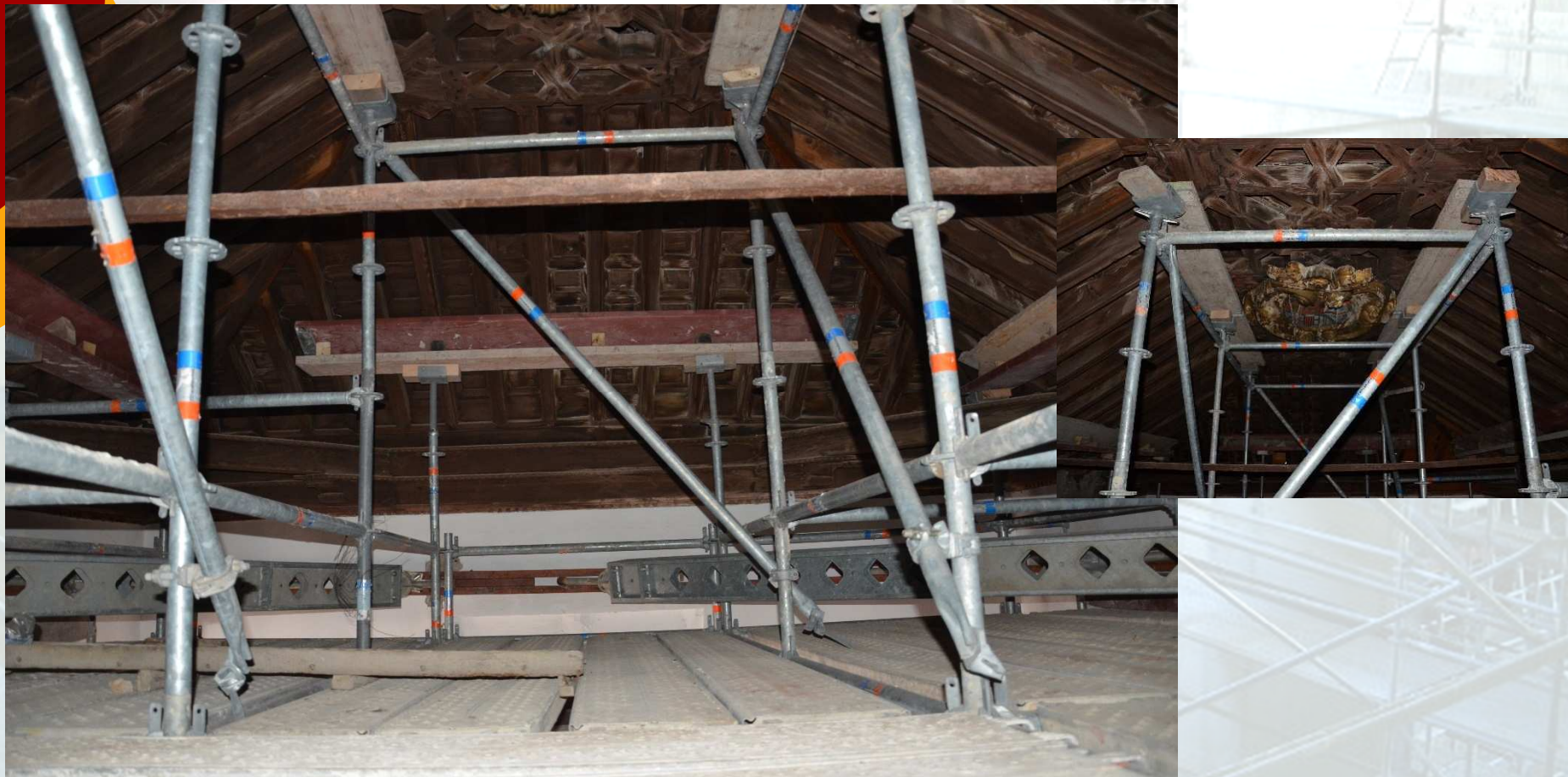
Hotel Oikos (Sevilla) Apuntalamiento del artesonado de la escalera principal.
