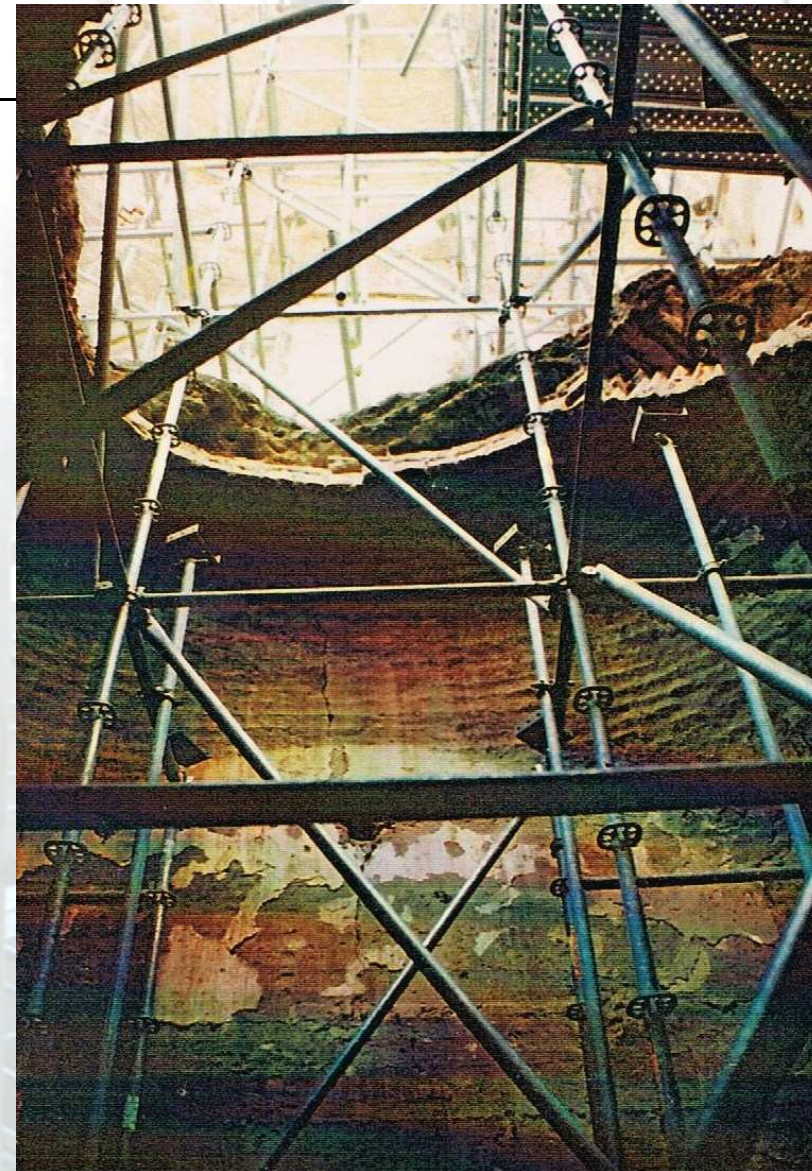
Castillo Luna Mairena del Alcor. Andamio exterior y apuntalamiento interior de bóvedas.
