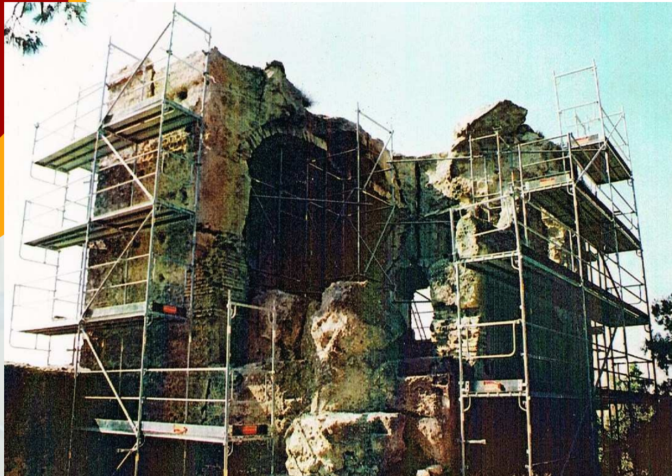
Castillo Luna Mairena del Alcor. Andamio exterior y apuntalamiento interior de bóvedas.
