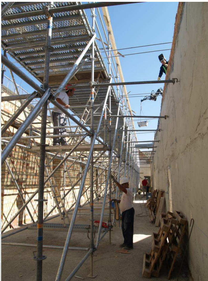
Ayuntamiento de Marchena. Apuntalamiento cubierta a dos aguas
