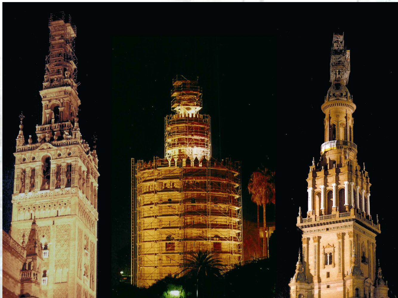
Montaje de andamios en las torres de Sevilla
