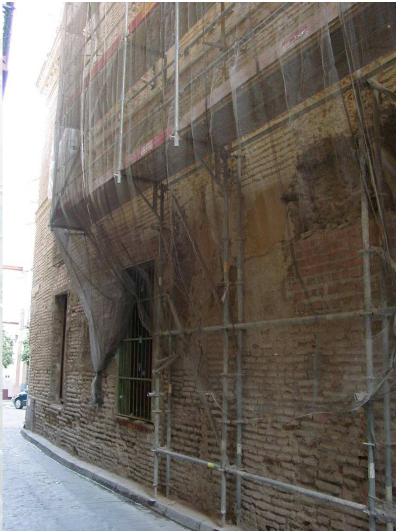
Andamio en calle con calzada y acerado muy estrecho (vuelo en lateral)
