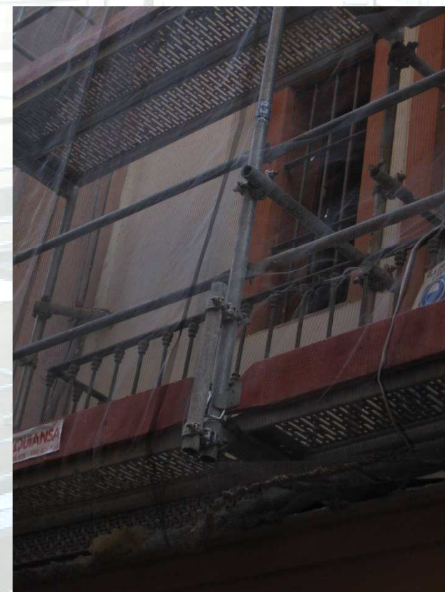
Andamio con pié central apuntalado y apoyado en balcón.
