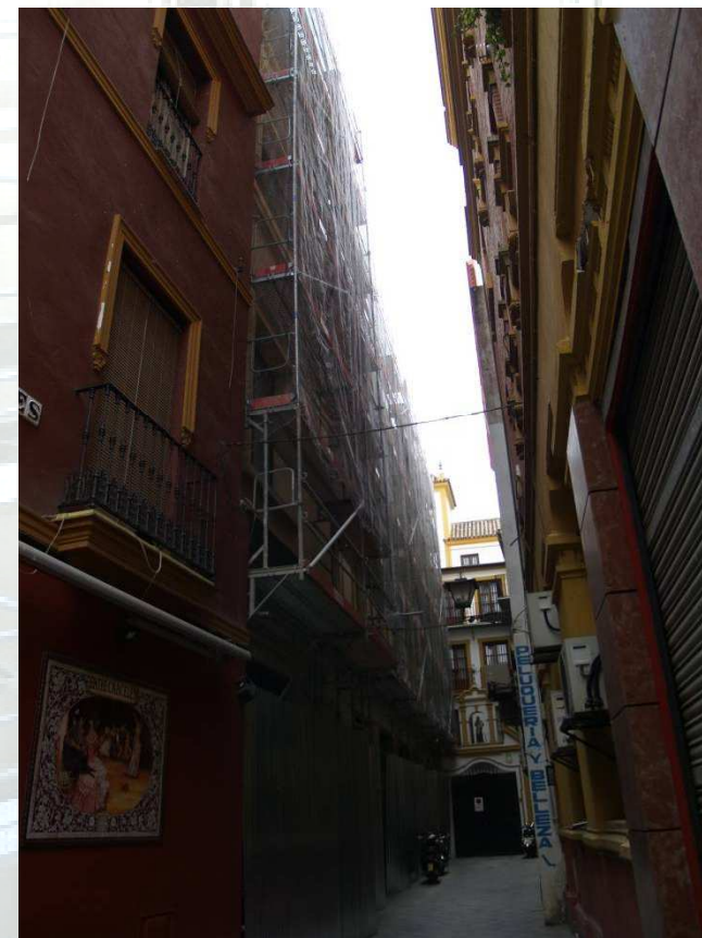
Andamio en calle estrecha con entrada de vehículos de urgencia
