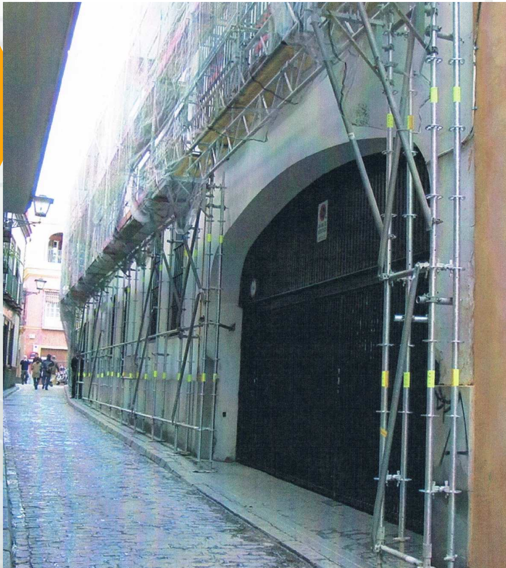
Andamio con pié estrecho y vigas de celosía para libra puerta de cochera de 7m. de longitud
