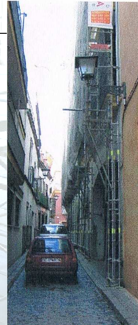
Andamio con pié estrecho y vigas de celosía para libra puerta de cochera de 7m. de longitud
