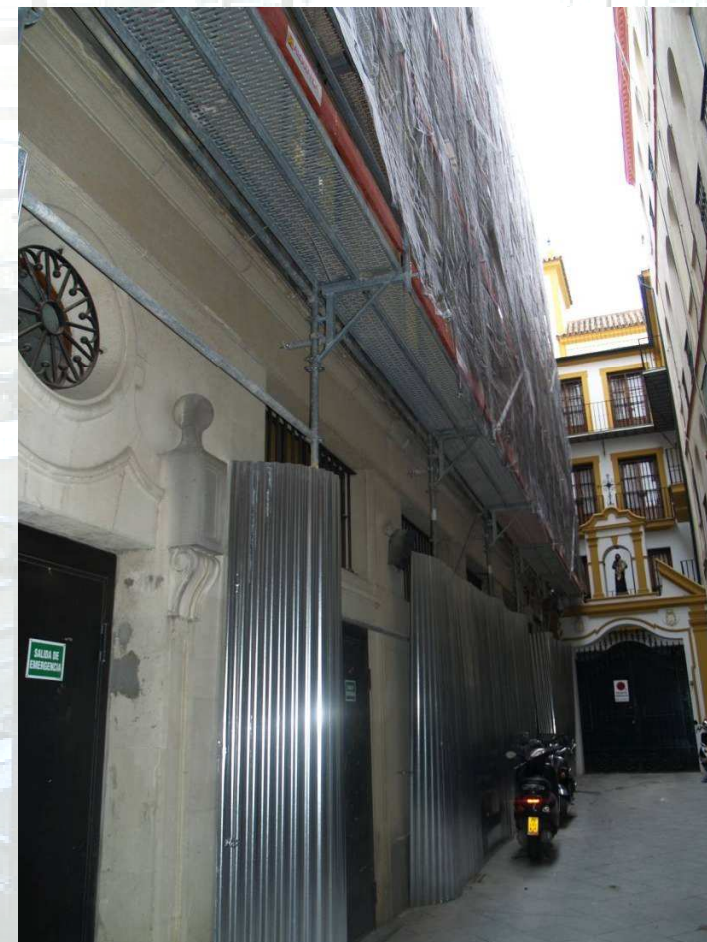
Andamios sobre un solo pié debido a la estrechez del acerado y de la calzada y por vuelo de cornisa
