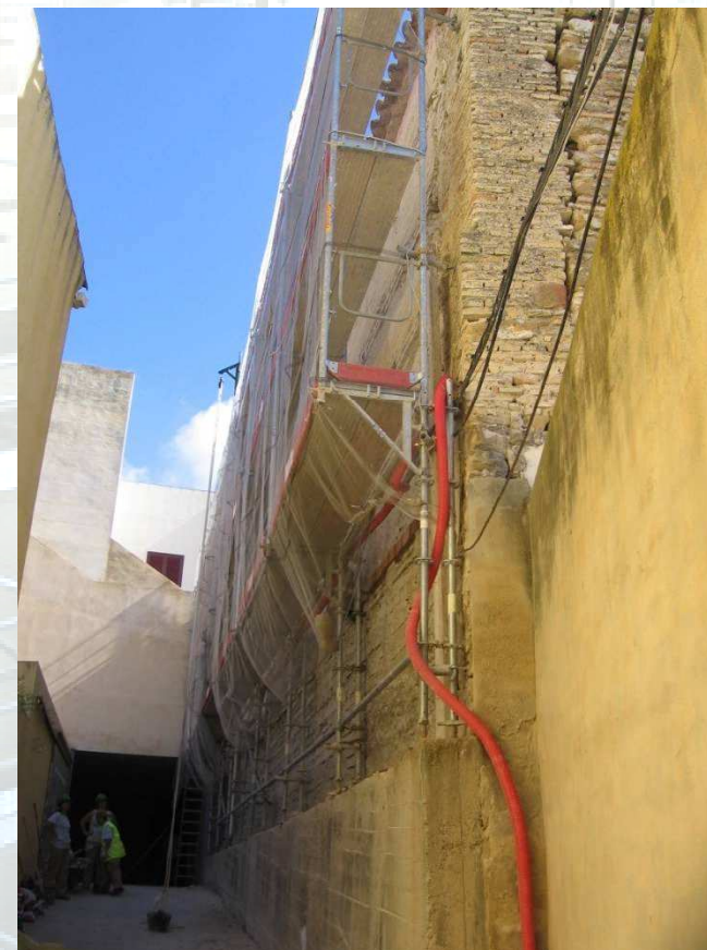
Andamio de pies estrechos sobre tacón de muro.
