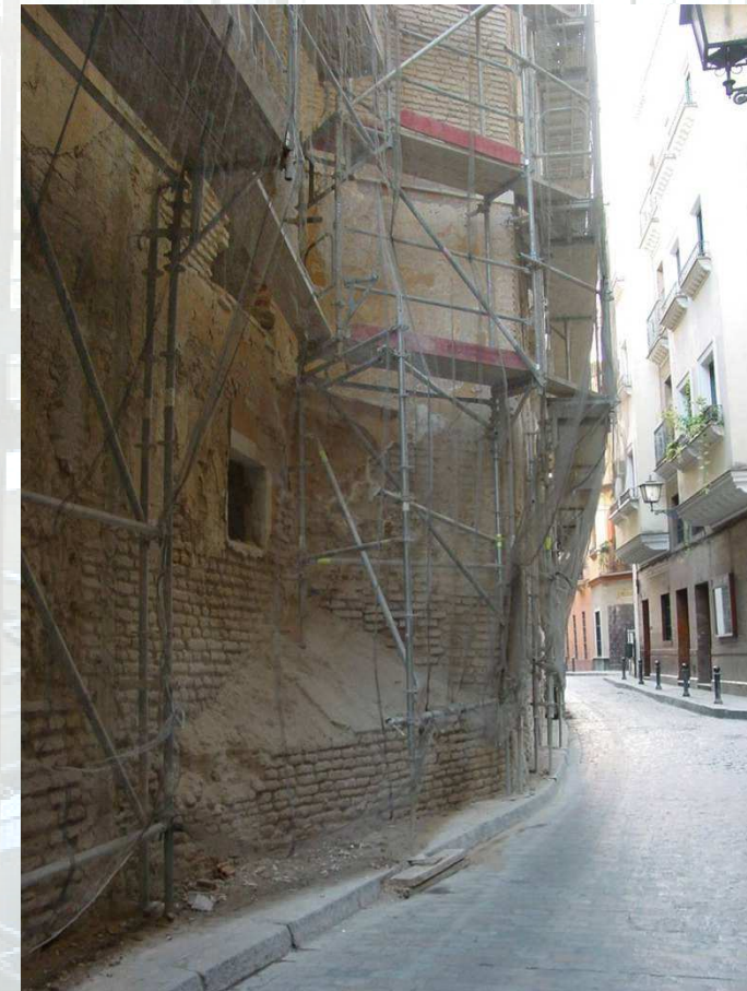
Andamio en calle con calzada y acerado muy estrecho (vuelo en lateral)
