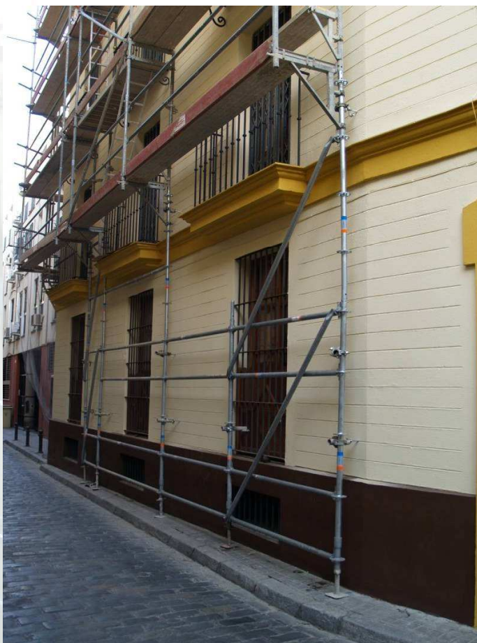
Andamios sobre un solo pié debido a la estrechez del acerado y de la calzada y por vuelo de cornisa
