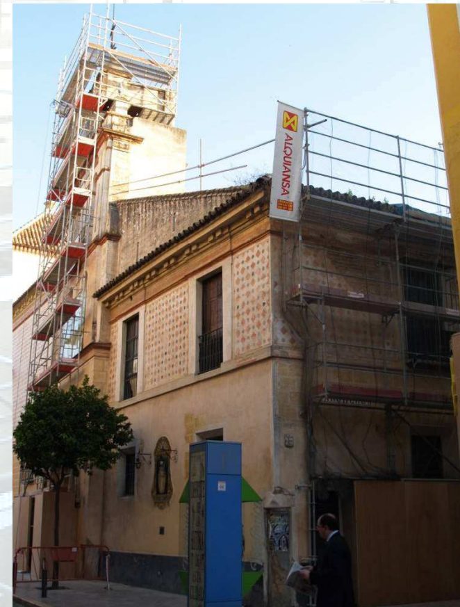
Andamio sobre pies estrechos debido a l estrechez de la calle(peatonal).
