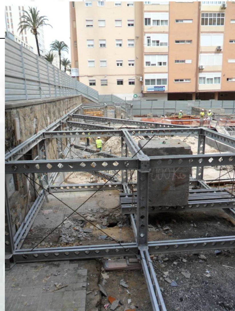
Muro Estadio Carranza (Cádiz) Estabilización exterior para contención de muro
