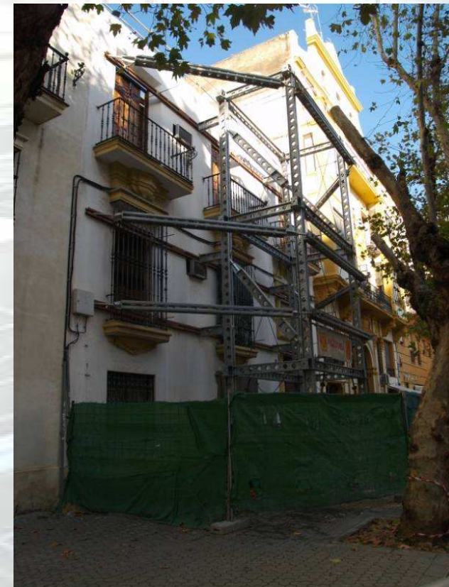
Estabilizador exterior con contrapeso de hormigón
