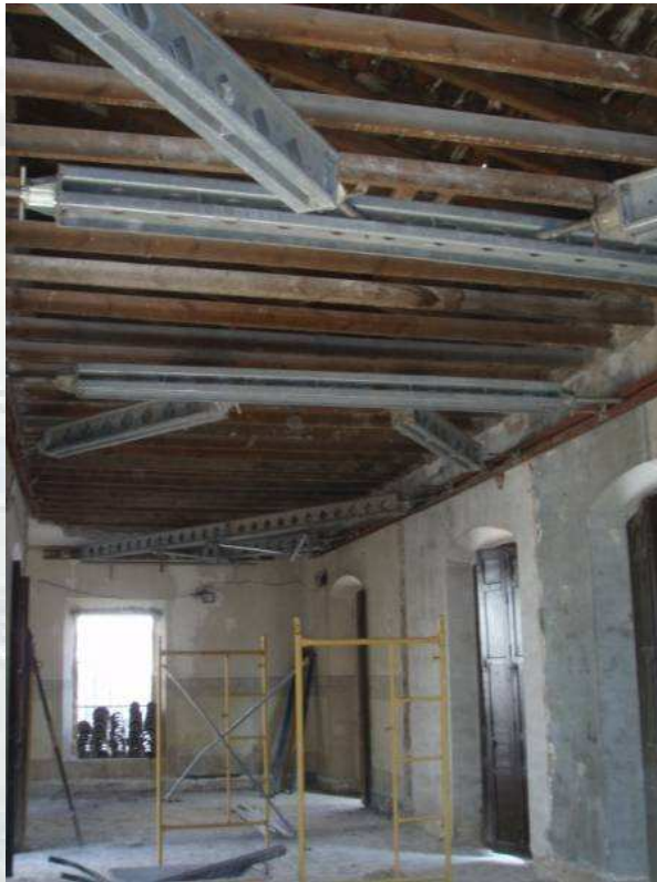
Edificio Herba ( San Juan de Aznalfarache) Estabilización interior entre muros colindantes en el primer edificio y entre medianeros en el segundo.
