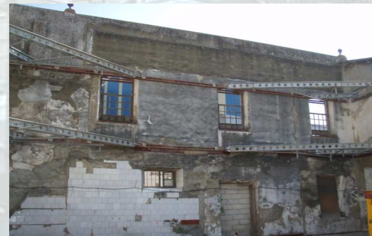
Edificio Herba ( San Juan de Aznalfarache) Estabilización interior entre muros colindantes en el primer edificio y entre medianeros en el segundo.
