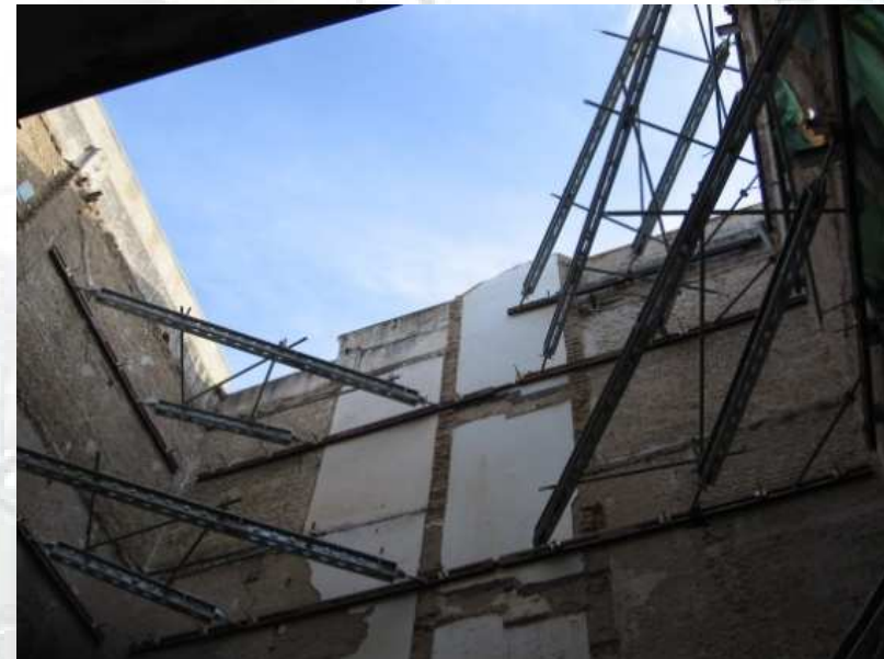
Estabilizador interior, vista interior (estructura Soldier) atado a medianeras.
