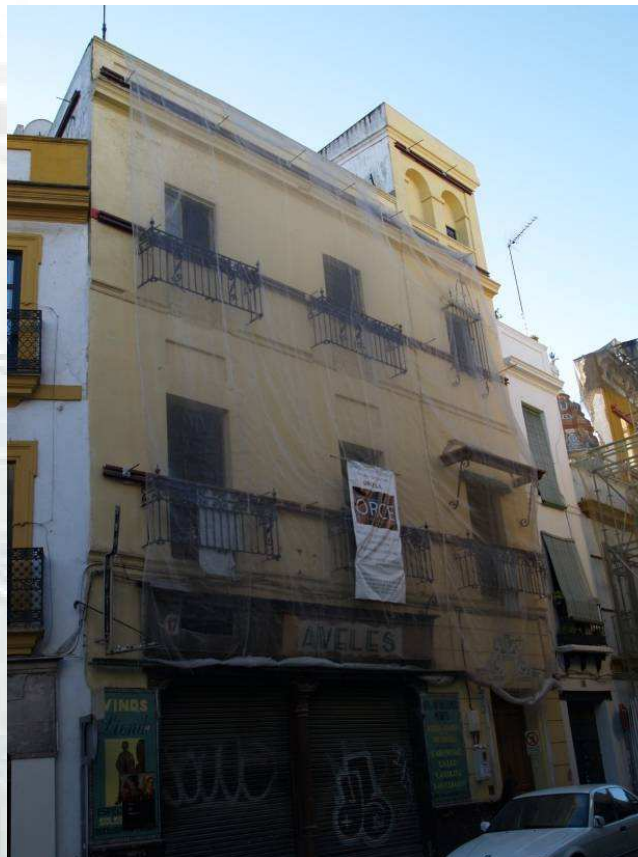
Estabilizador interior ,correas de atado de fachada.
