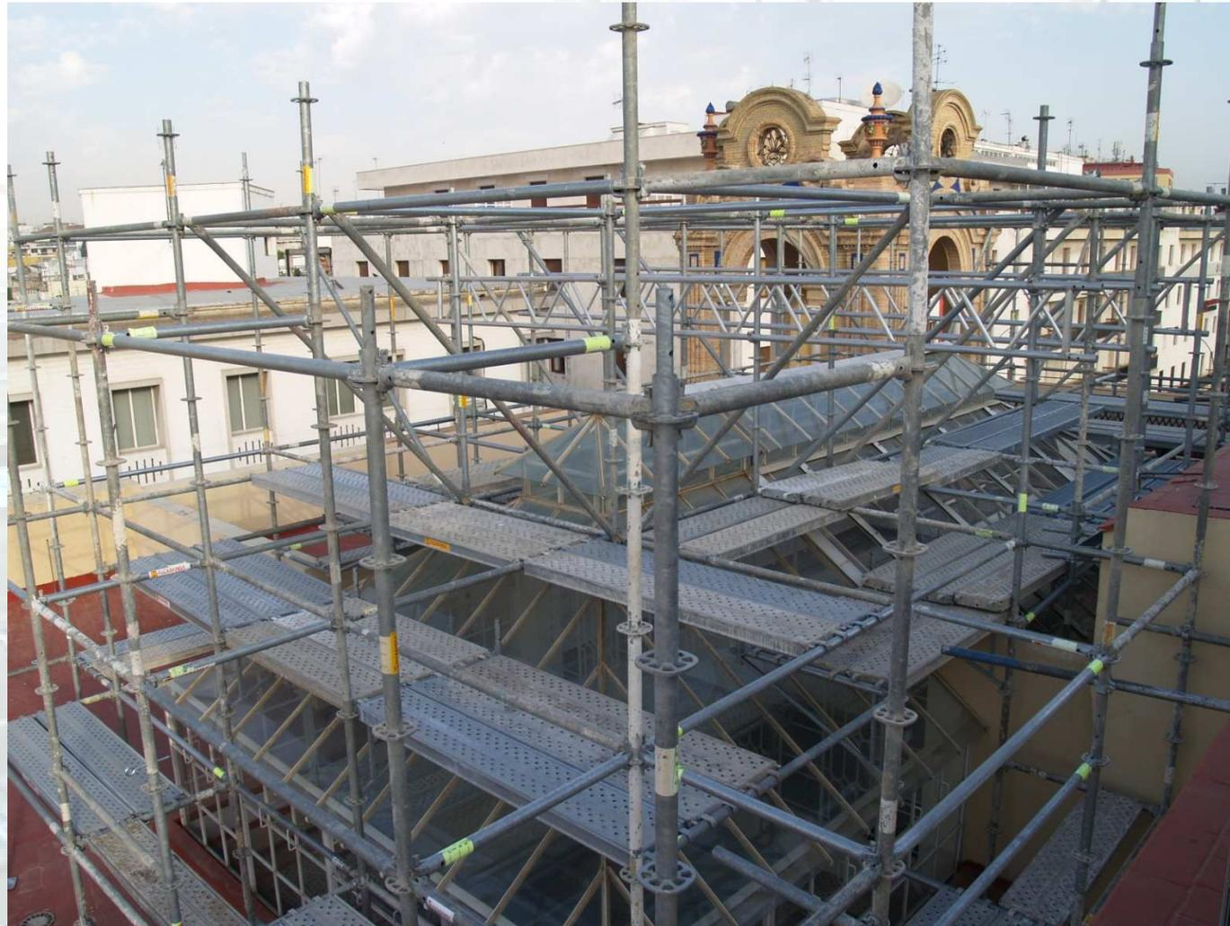
Para evitar el apoyo en los pies centrales se utilizan consolas y vigas de celosía entre los pies apoyados en el suelo.
