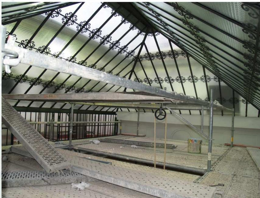
Vista interior de la montera con plataforma adaptada a la forma de la misma para trabajar por debajo.
