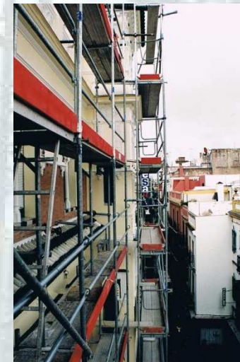
Edif. Ciudad de Londres c/Cuna-Sevilla (1912-1914) Arquitecto José Espiau y Muñoz Edif. Neomudéjar. Edificio singular en su forma, el andamio montado se adapta a la balconera semicircular y permite el paso a lo largo del mismo pese a las zonas entrantes y salientes que presenta.
