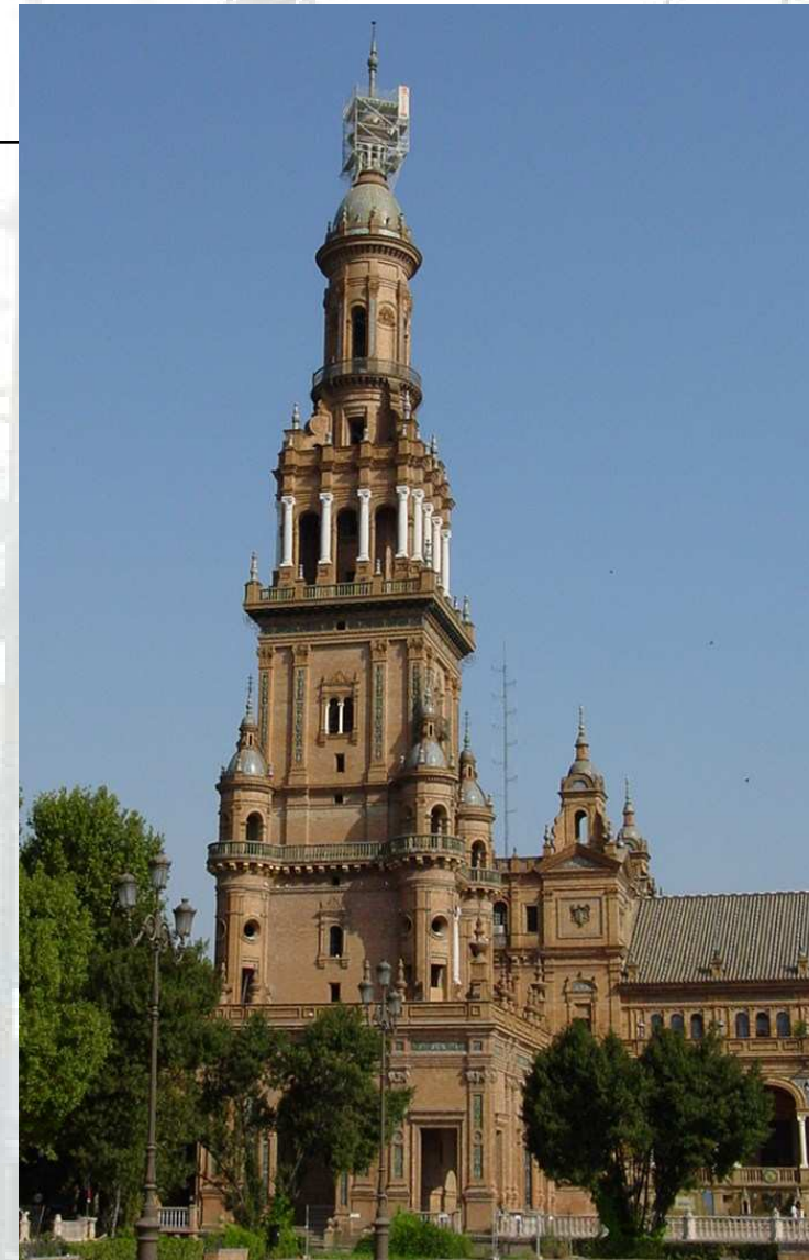
Torre Norte Plaza de España (Sevilla) Arq. Aníbal González (1914-1928) Andamio para cambio de pararrayos. Estructura que volada desde el último cuerpo de la torre.
