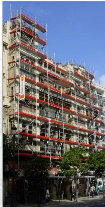
Edif. Adriática. Avda. Constitución-Sevilla(1914-1922) Arquitecto José Espiau y Muñoz Edif. Neomudéjar. En este edificio se monta el andamio adaptado a los entrantes y a la forma circular de los balcones del frente de fachada, sobre dichos balcones el andamio se remete; en los extremos medineros con consolas se permite trabajar dichas zonas sin invadir las fachada vecinas.
