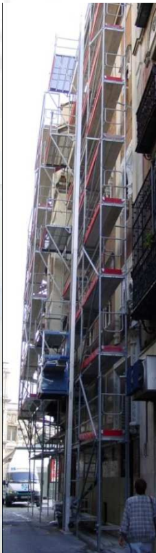
Edif. Adriática. Avda. Constitución-Sevilla(1914-1922) Arquitecto José Espiau y Muñoz Edif. Neomudéjar. En este edificio se monta el andamio adaptado a los entrantes y a la forma circular de los balcones del frente de fachada, sobre dichos balcones el andamio se remete; en los extremos medineros con consolas se permite trabajar dichas zonas sin invadir las fachada vecinas.
