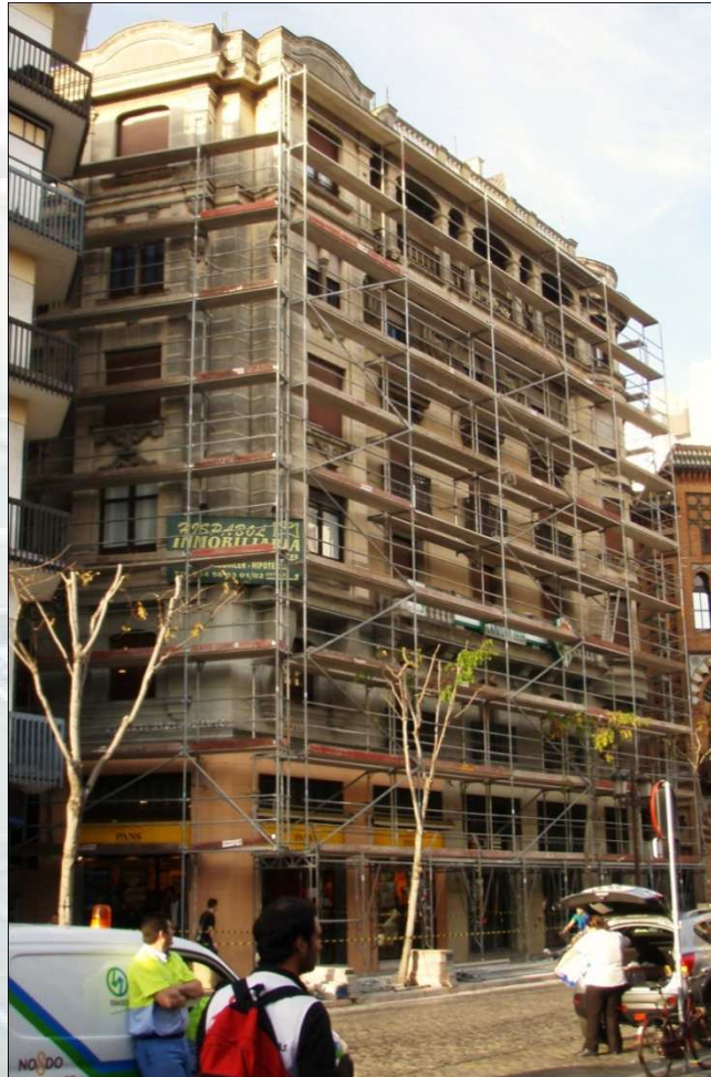
Edif. Raafel Lora Santa María de Gracia (Sevilla) Proy. Ramón Cortazar. Direc. Obra: Juan Talavera Heredia Edificio complejo con entrantes que nos obligan a montar un doble andamio al interior en las fachadas de La Campana y de Santa María de Gracia, con chafalán semicircular en la esquina que parte de la tercera planta.
