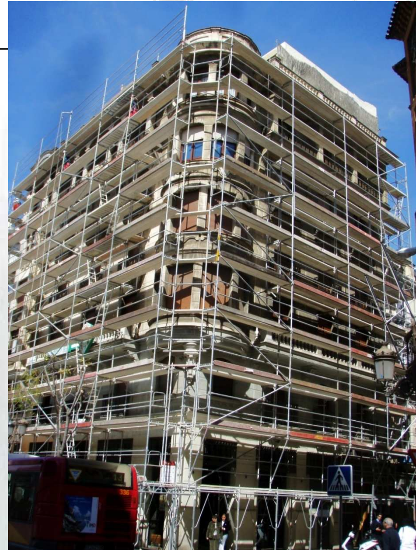
Edif. Raafel Lora Santa María de Gracia (Sevilla) Proy. Ramón Cortazar. Direc. Obra: Juan Talavera Heredia Edificio complejo con entrantes que nos obligan a montar un doble andamio al interior en las fachadas de La Campana y de Santa María de Gracia, con chafalán semicircular en la esquina que parte de la tercera planta.
