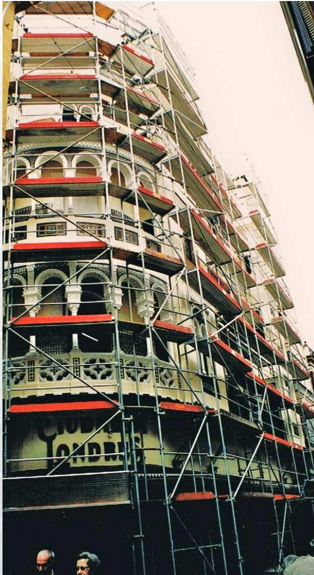
Edif. Ciudad de Londres c/Cuna-Sevilla (1912-1914) Arquitecto José Espiau y Muñoz Edif. Neomudéjar. Edificio singular en su forma, el andamio montado se adapta a la balconera semicircular y permite el paso a lo largo del mismo pese a las zonas entrantes y salientes que presenta.
