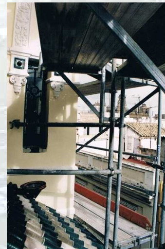
Edif. Ciudad de Londres c/Cuna-Sevilla (1912-1914) Arquitecto José Espiau y Muñoz Edif. Neomudéjar. Edificio singular en su forma, el andamio montado se adapta a la balconera semicircular y permite el paso a lo largo del mismo pese a las zonas entrantes y salientes que presenta.
