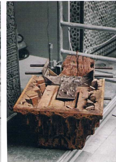
FIG. 98. Cuatro momentos del proceso de montaje (ensayos previos), y su adaptación, manteniendo liberada la quicalera original. (TCR).
