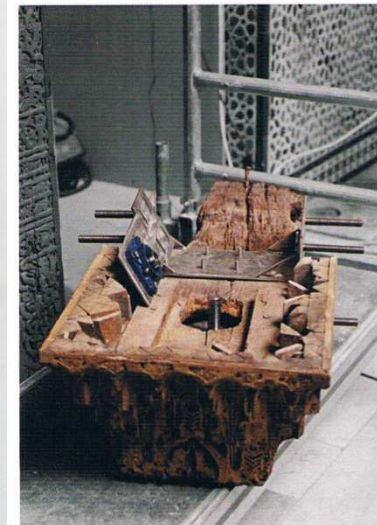
FIG. 98. Cuatro momentos del proceso de montaje (ensayos previos), y su adaptación, manteniendo liberada la quicalera original. (TCR).
