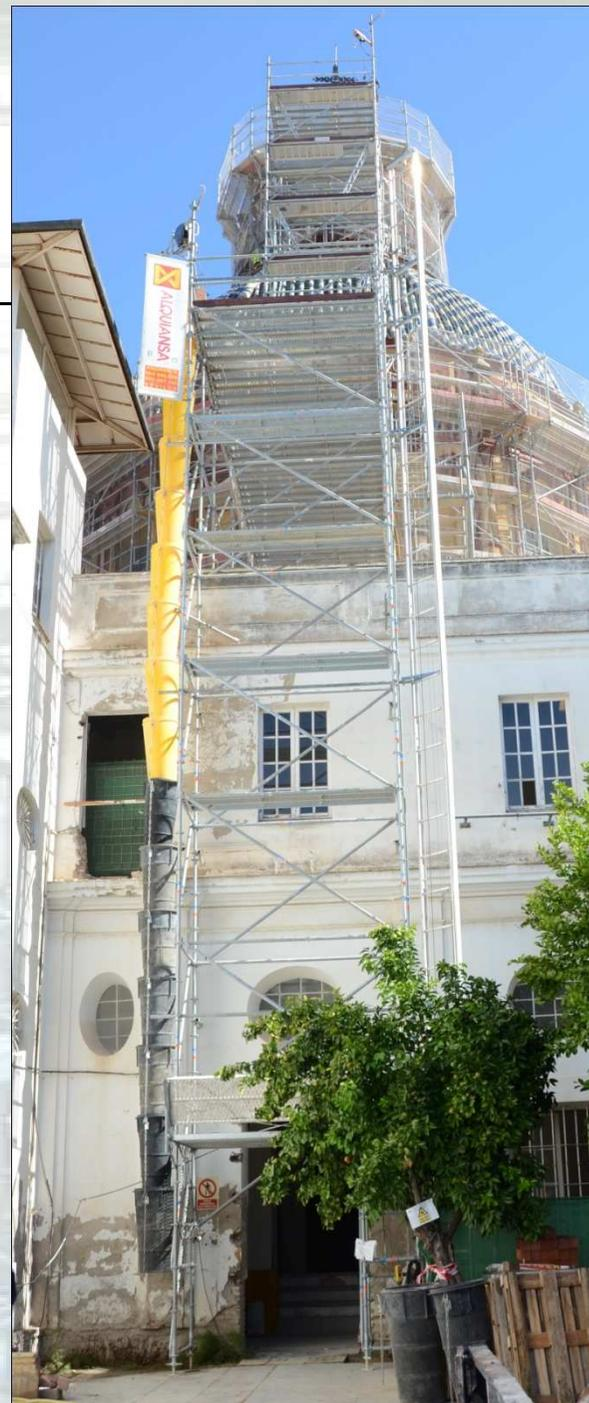
A estructura multidireccional con pasarela superior, con detalle de desembarco.
