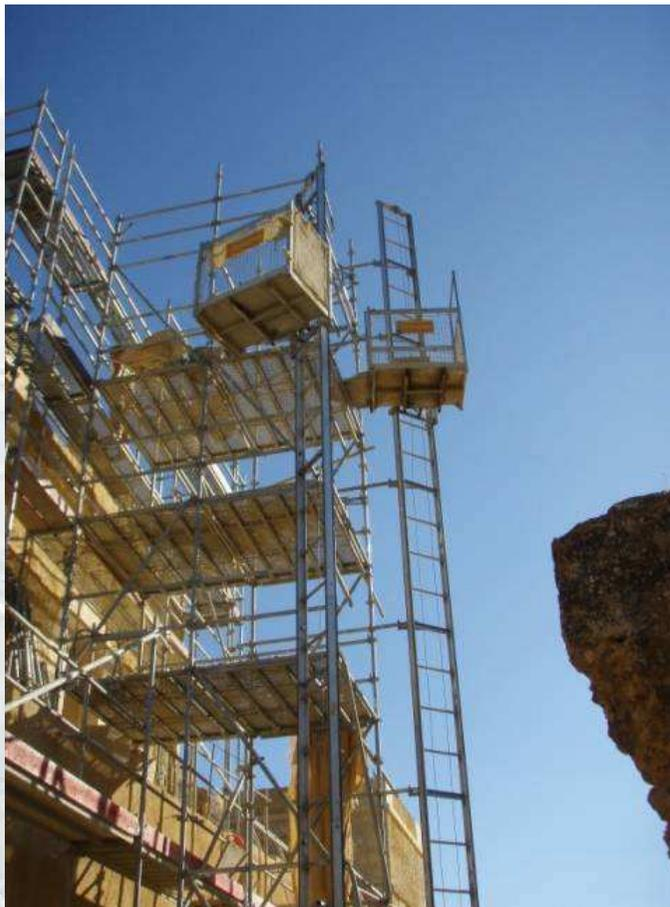
Dos montacargas sobre una torre para agilizar los trabajos y tres niveles de desembarco.
