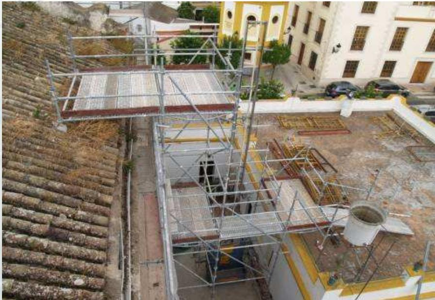
Montacargas con dos alturas de desembarco y rampa intermedia
