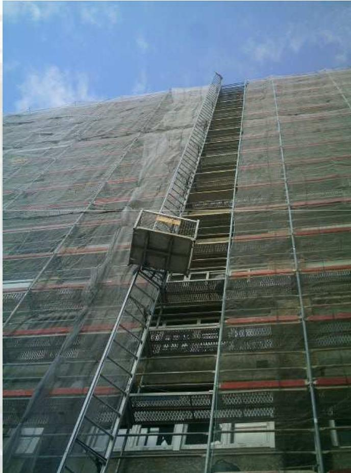
Dos montacargas instalados en un andamio perimetral al edificio con posibilidad de descarga en todos los niveles de plataformas.
