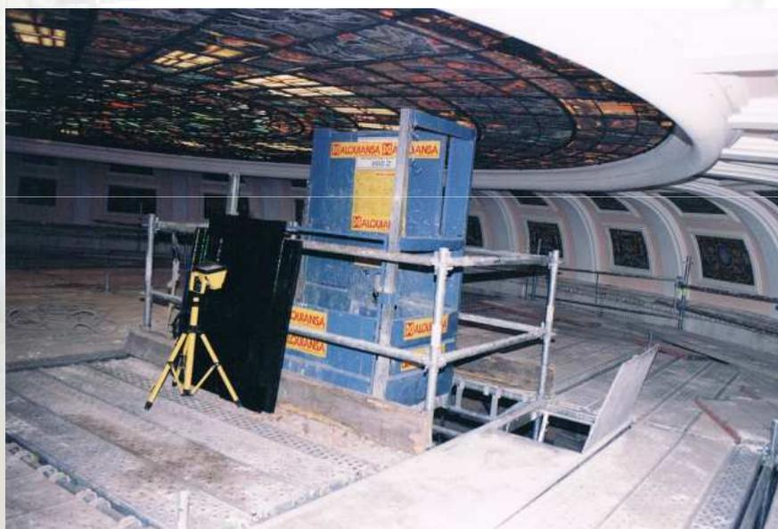
Descarga en plataforma de andamio multi-direccional para la restauración de vidriera
