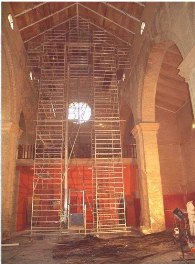
Montacargas sobre torre doble móvil para subir placas
