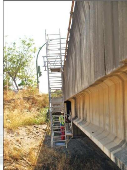
Torre móvil con estructura descolgada que permite trabajar el lateral del puente para colocación de instalaciones
