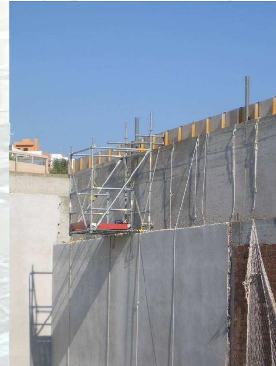
Torre colgada en pantalla para colocación de placas de anclaje.
