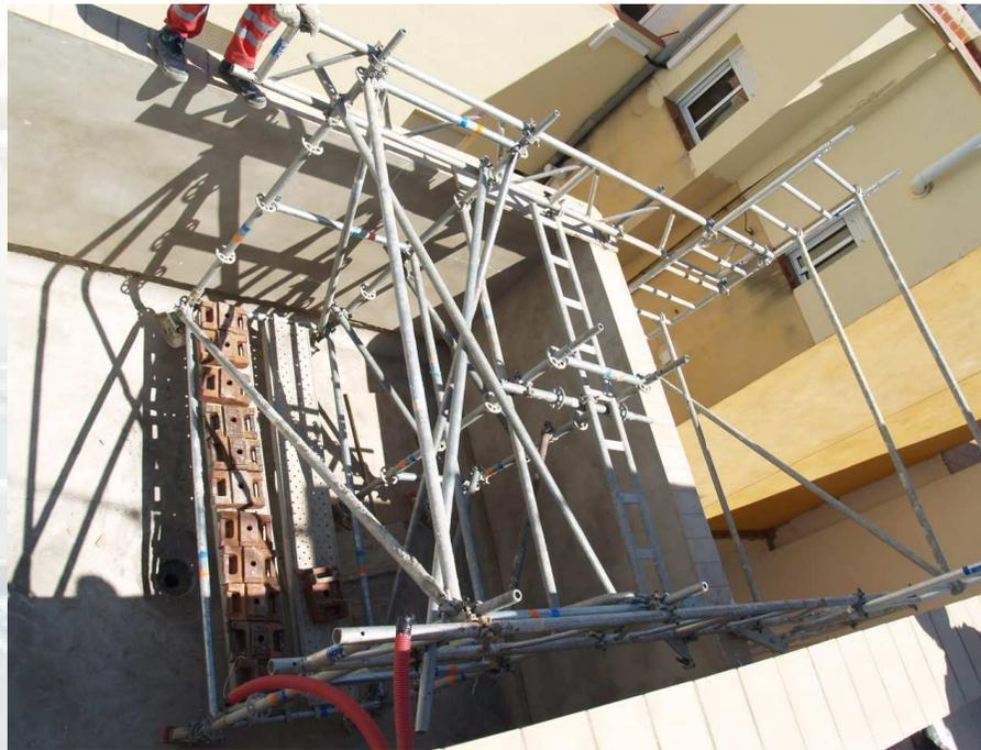
Torre móvil descolgada para trabajos en medianeras, (diseñada para girar en la esquina)
