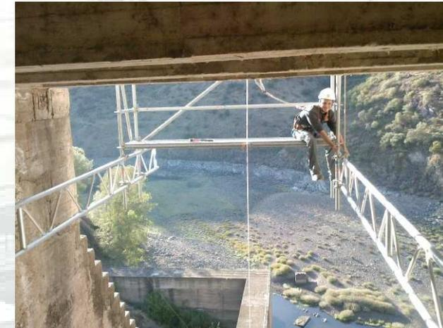
Torre móvil con estructura descolgada que permite trabajar los bajos del tablero de un embalse.
