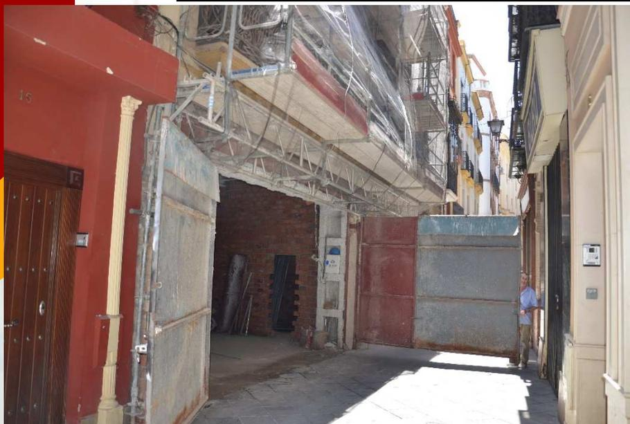
Protección de entrada a obra mediante doble ménsula en andamio que parte con piezas estrechas y puente de viga para dejar libre la entrada de camiones a obra en una calle peatonal estrecha.
