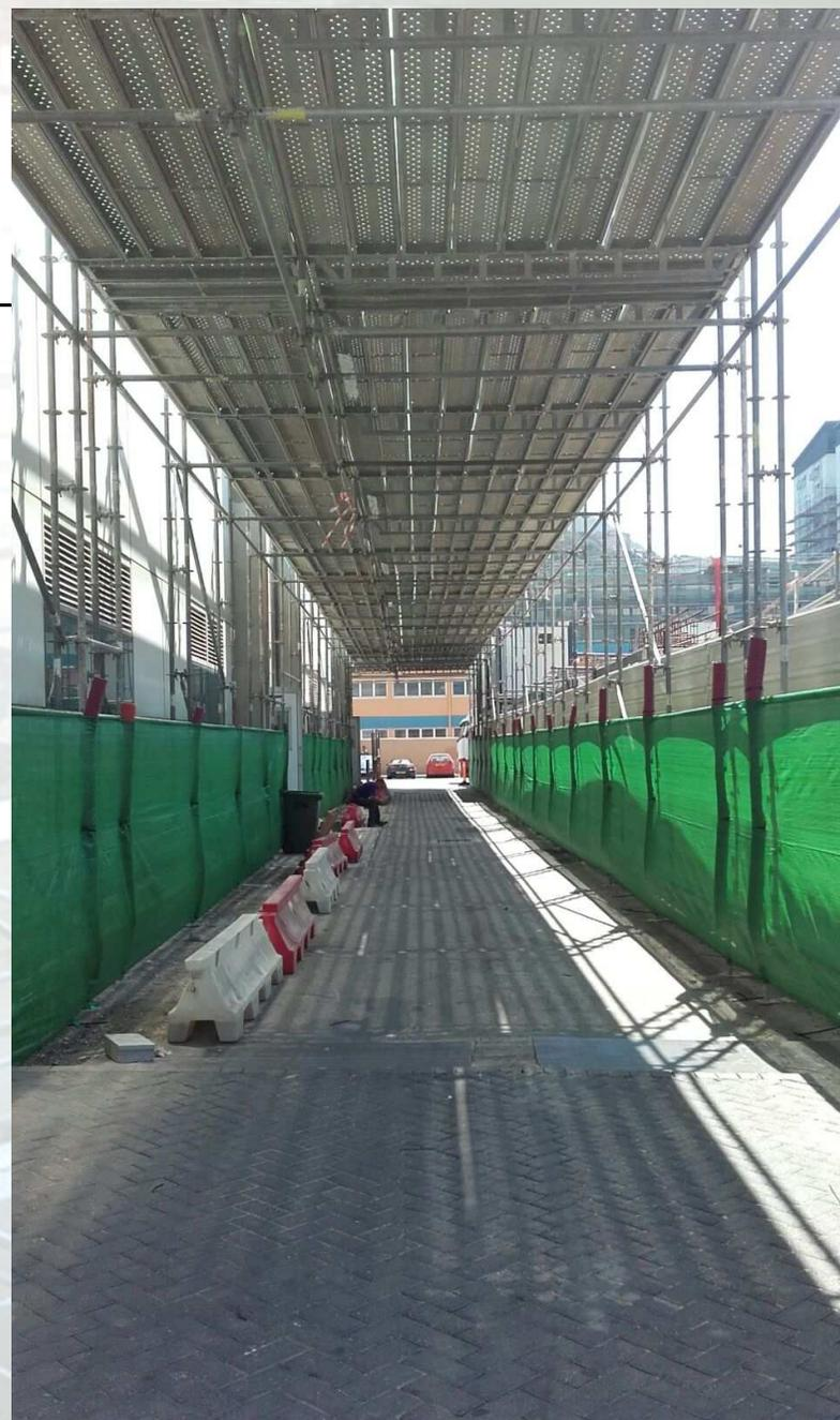
Base de paso con andamio multidireccional que permite el paso de vehículos y peatones en vía pública durante el periodo de construcción de un edificio.
