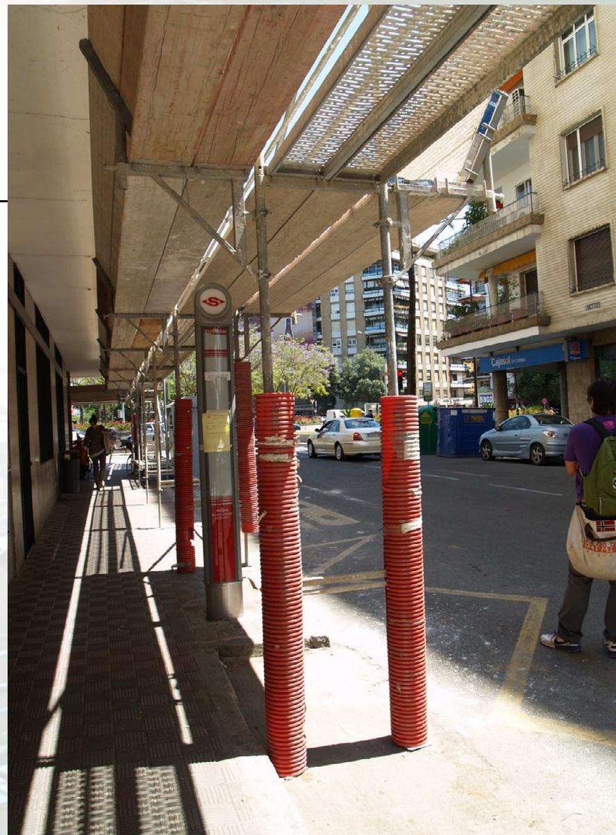
Protecciones con ménsulas y viseras en el exterior e interior del andamio para protección de los viandantes.
