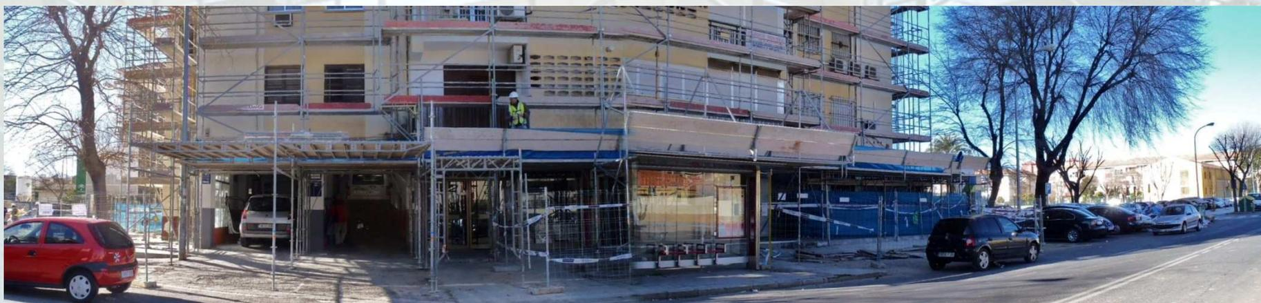
Protecciones en el frente de un bloque de viviendas con bases de paso que protegen las entradas a comercios taller y parada de autobús.
