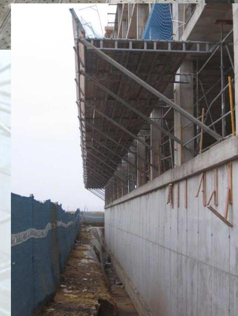
Protección realizada con andamio multidireccional y vuelo de visera de 3m. con soportes de plataformas y diagonales así como visera.
