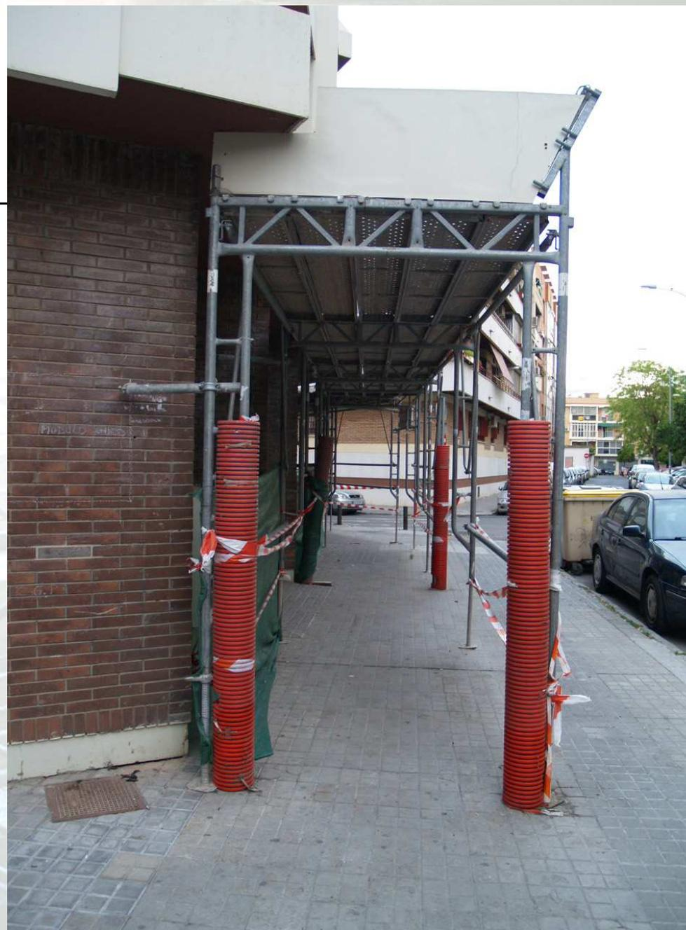
Base de paso de 1,65m con visera y protección lateral durante las obras de rehabilitación del edificio.
