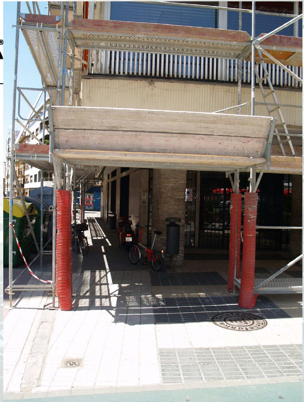
Protección de la entrada a soportal que sirve de base de paso durante la ejecución de las obras.
