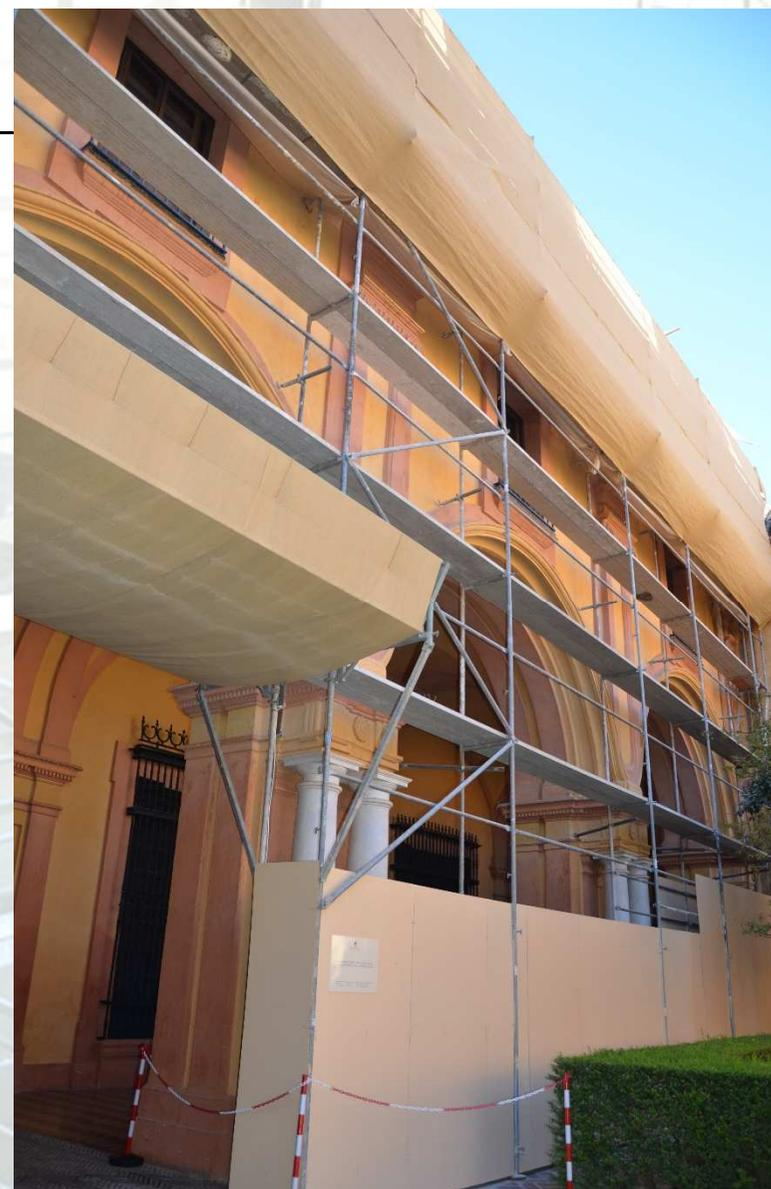
Protección mediante consola y visera al exterior e interior de la entrada de público en el Salón Gótico de los Real Alcázar de Sevilla.
