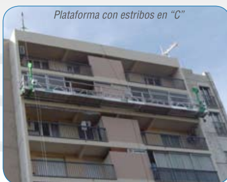
Plataforma suspendida de 6 m longitud con elevadores eléctricos y liras extremas
