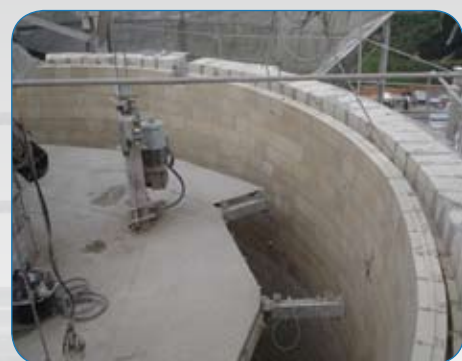
Plataforma suspendida circular con 3 elevadores eléctricos
