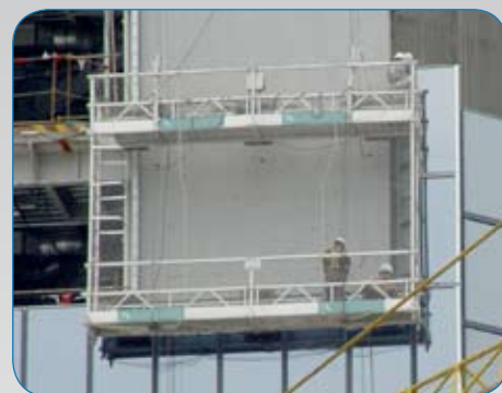
Plataforma de 6 m de longitud de doble piso
