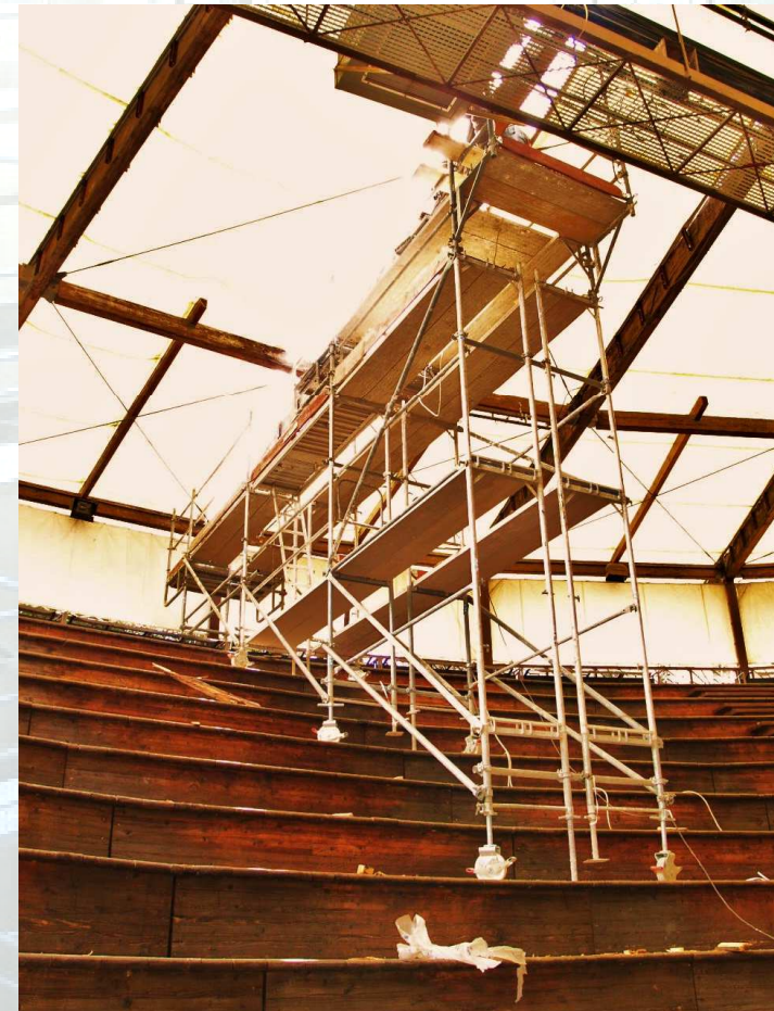
Isla Mágica, Circo del Cóndor (Sevilla). Torre móvil adaptada al desnivel de las gradas semicirculares y la pendiente de un techo.
