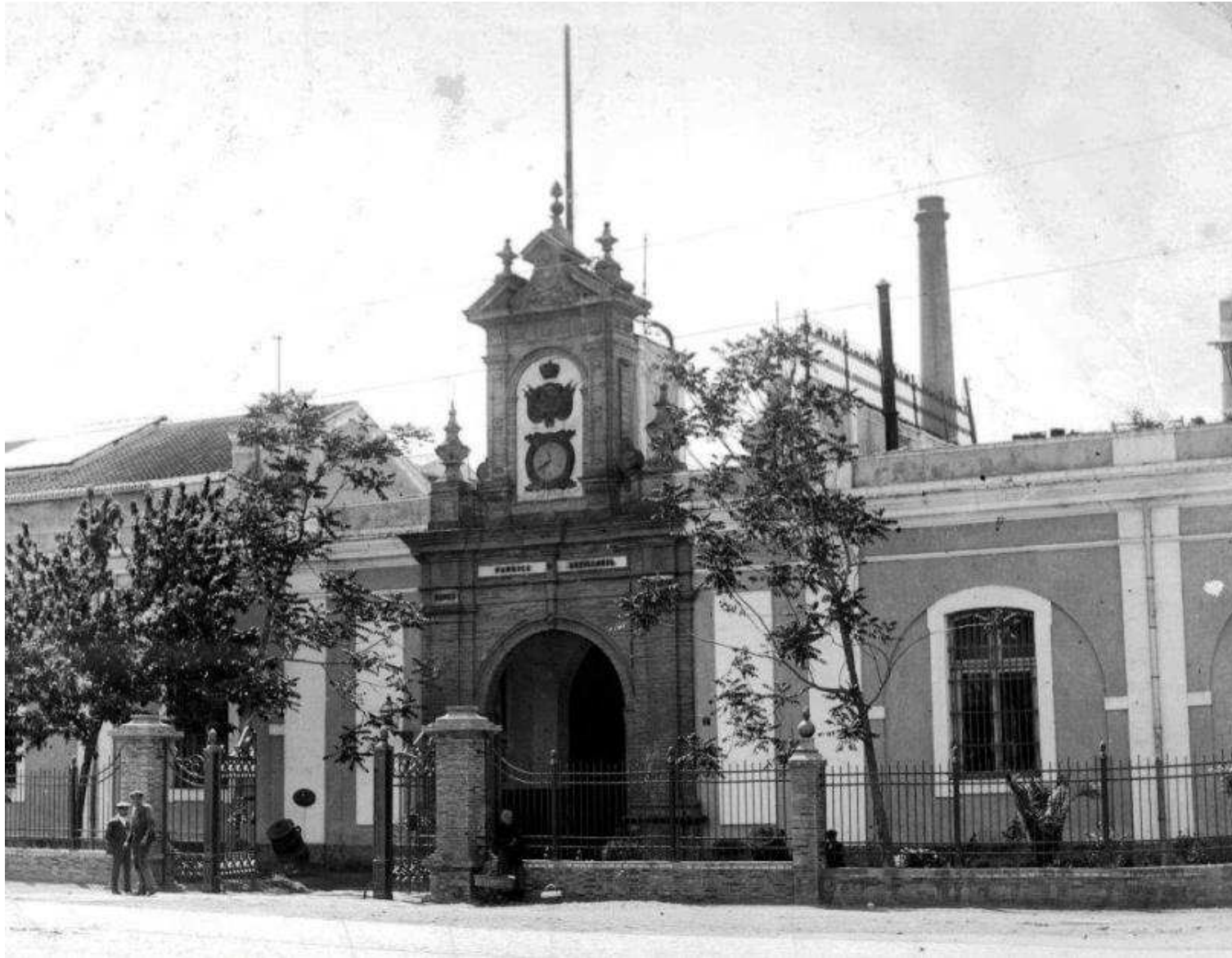
Real Fábrica de Artillería, fachada principal
