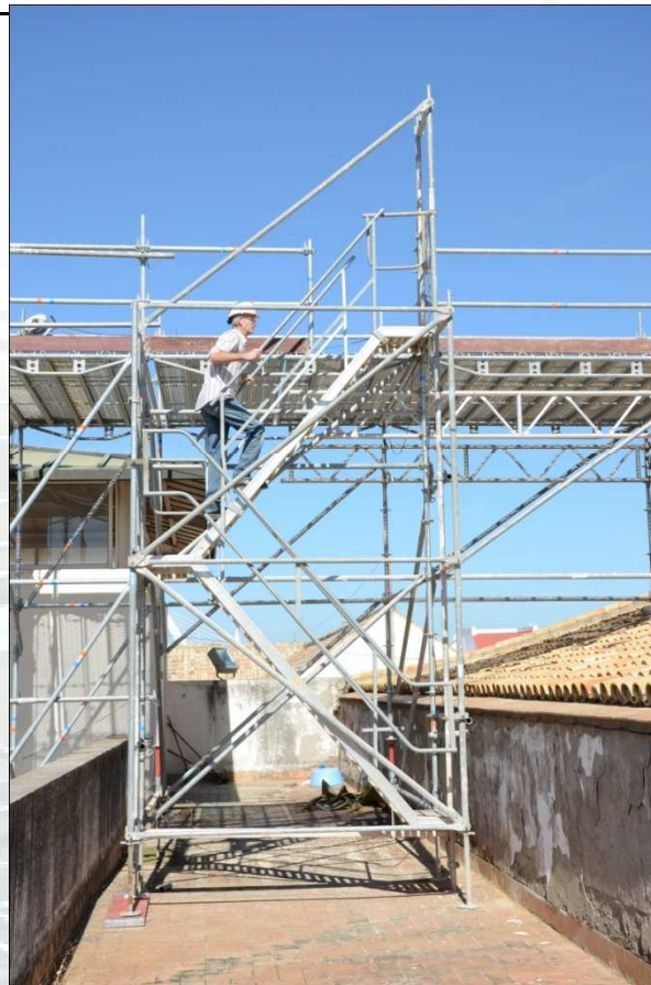
Iglesia de San Luis (Sevilla) Plataforma segundo nivel acceso linterna. Escalera manos libre acceso a primera plataforma. Plataforma acceso al tambor cúpula con montacargas y trompa de evacuación de escombros.
