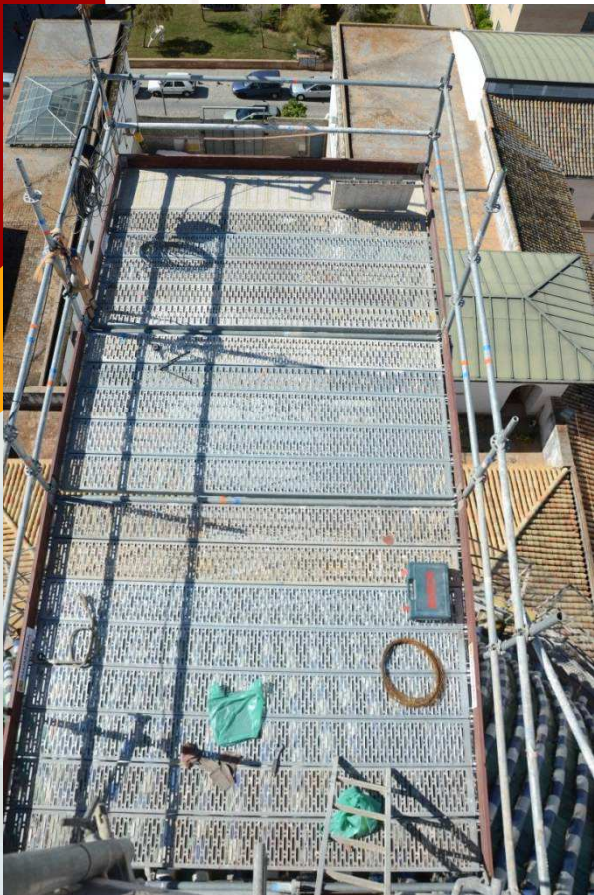
Iglesia de San Luis (Sevilla) Plataforma segundo nivel acceso linterna. Escalera manos libre acceso a primera plataforma. Plataforma acceso al tambor cúpula con montacargas y trompa de evacuación de escombros.
