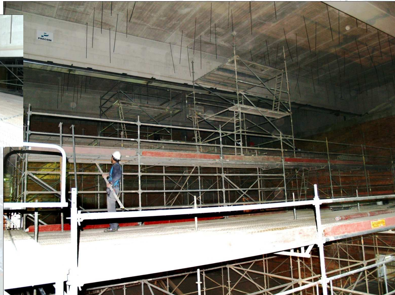
Teatro Alcalá de Guadaira (Sevilla) Plataforma escalonada para el trabajo en el techo y andamios laterales para los paramentos
