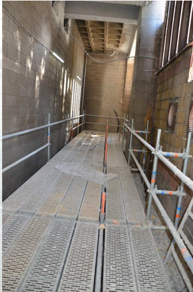
Centro comercial Los Arcos (Sevilla) Plataforma en hueco de instalaciones, con apoyos puntuales, por dejado de la misma el vacío de tres niveles de sótano
