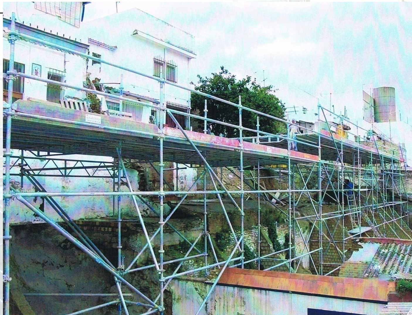
Pasarela para máquina de pilotaje en San Juan de Aznalfarache.
