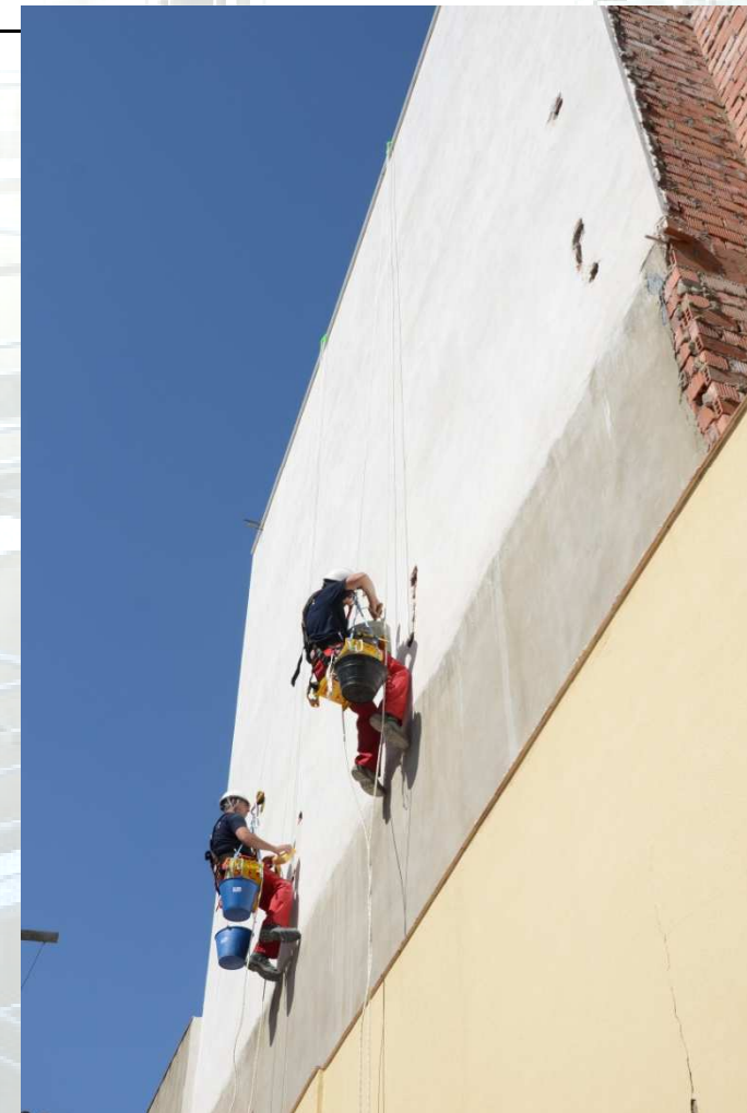
Reparación paramento de monocapa en fachada medianera del edificio.
