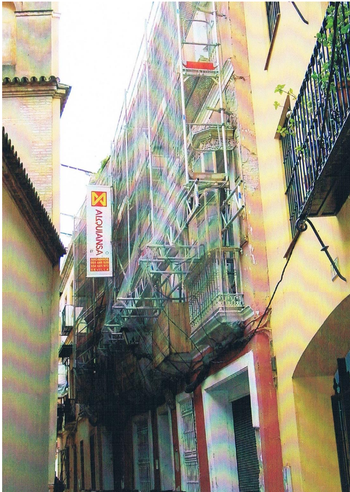
Andamio volado partiendo desde estructura apuntalada en la primera planta del edificio.
