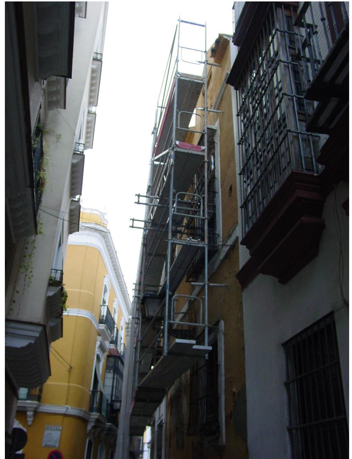
Andamio descolgado desde estructura apuntalada en la primera planta del edificio.
