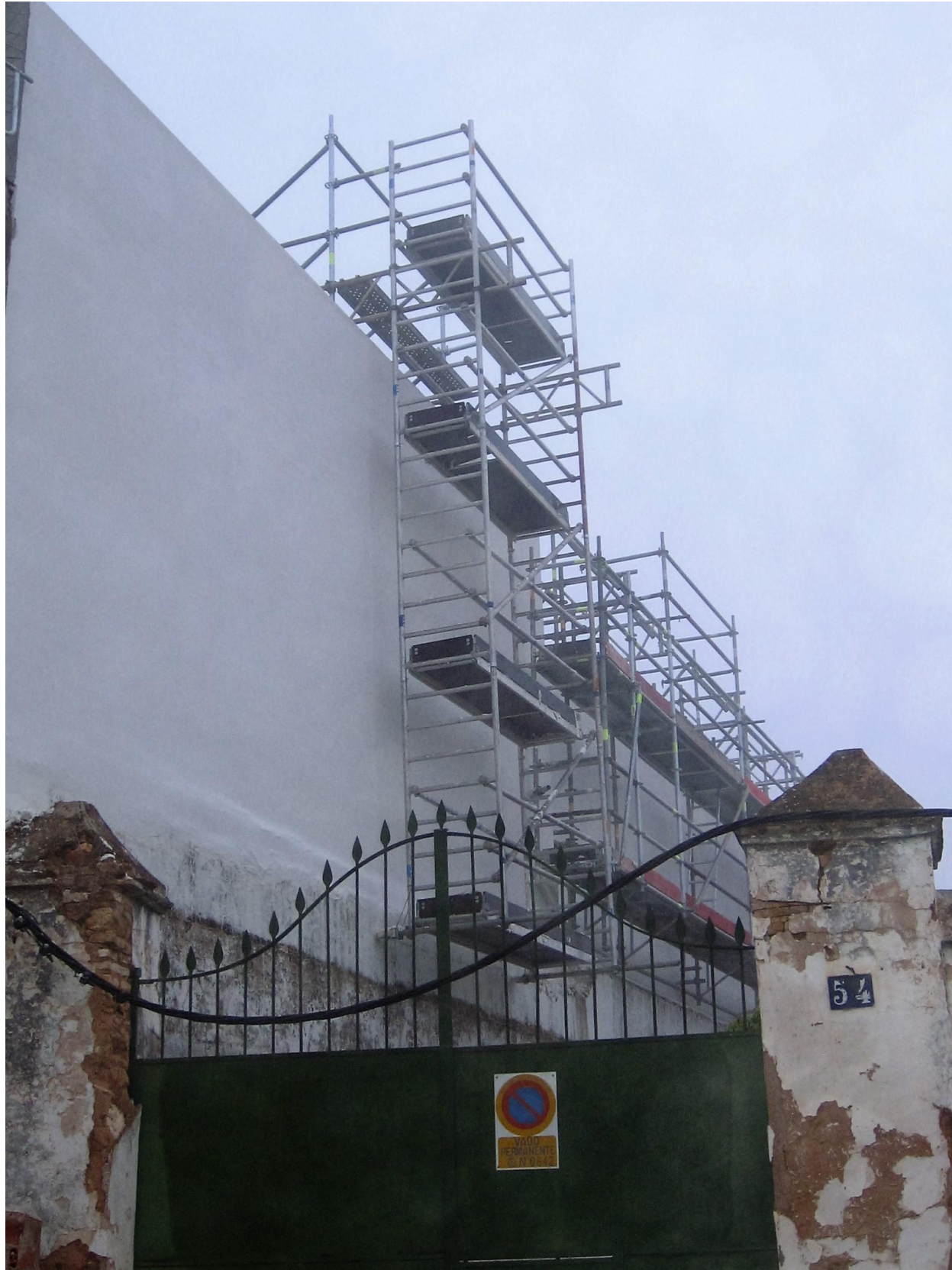
Montaje en zona de medianeras partiendo de resalte en un tramo y con torre móvil contrapesada en el segundo tramo.
