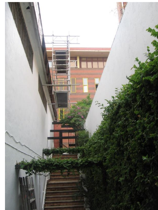
Torre móvil contrapesada para trabajar el canto de un forjado en zona de escalera de acceso.
