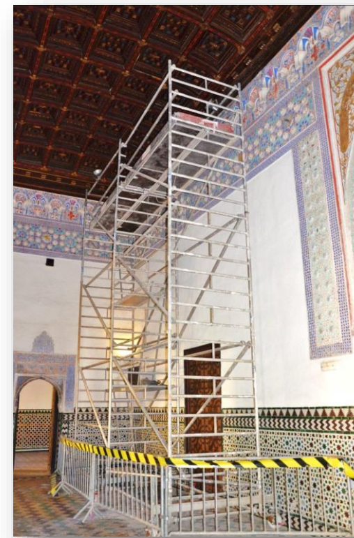
Trabajos en frisos.
