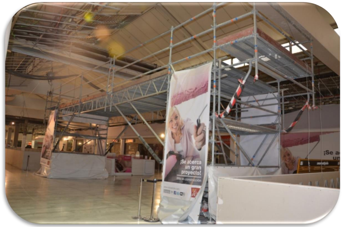
Trabajos en falsos techos centro comercial.
