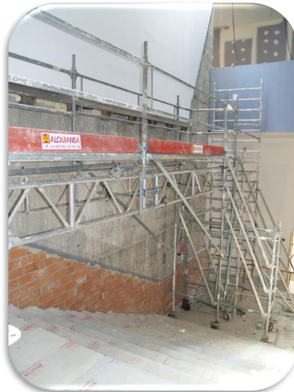
Montaje en escalera.
