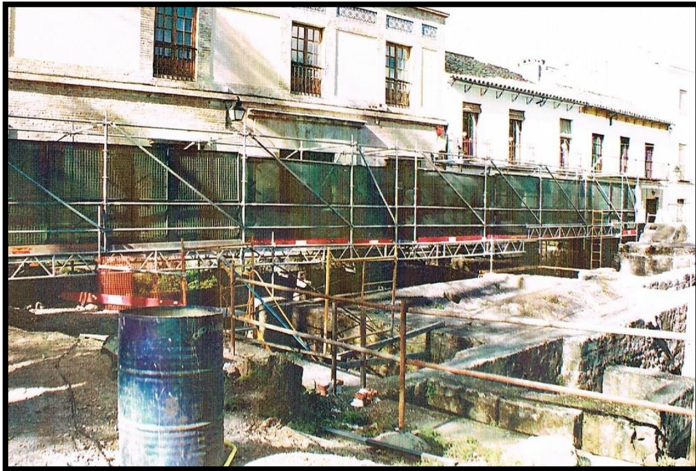
Pasarela de acceso provisional a viviendas durante la restauración de los Baños Califales de Córdoba.
