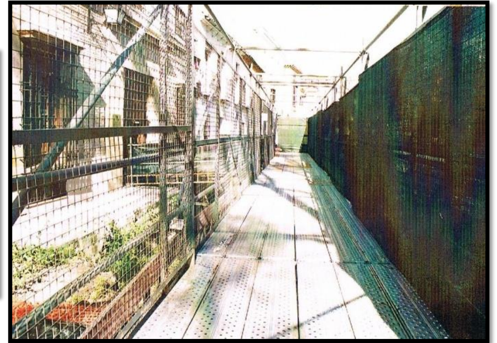
Pasarela de acceso provisional a viviendas durante la restauración de los Baños Califales de Córdoba.
