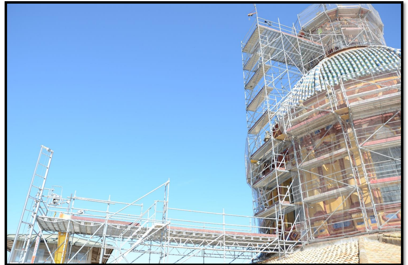
Pasarela de acceso provisional a viviendas durante la restauración de los Baños Califales de Córdoba.
