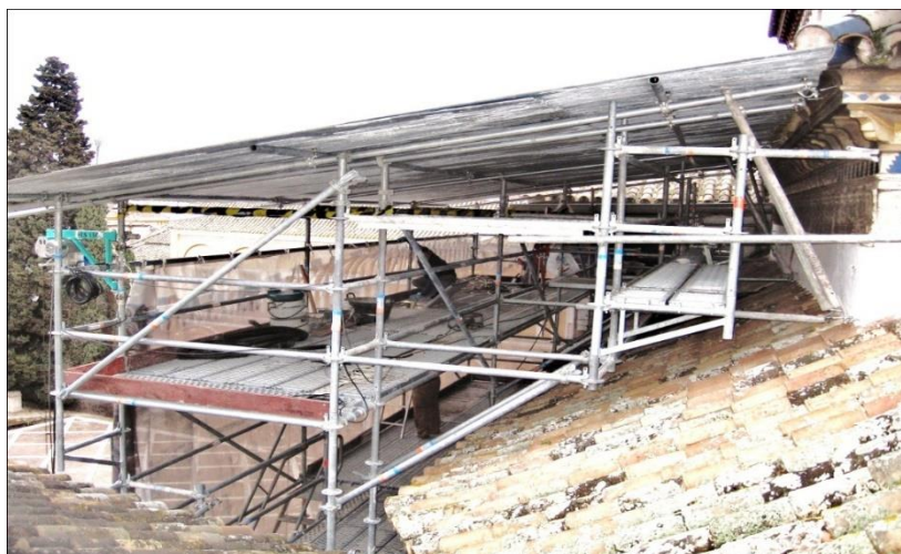
Restauración de la puerta del Palacio de Pedro I.
