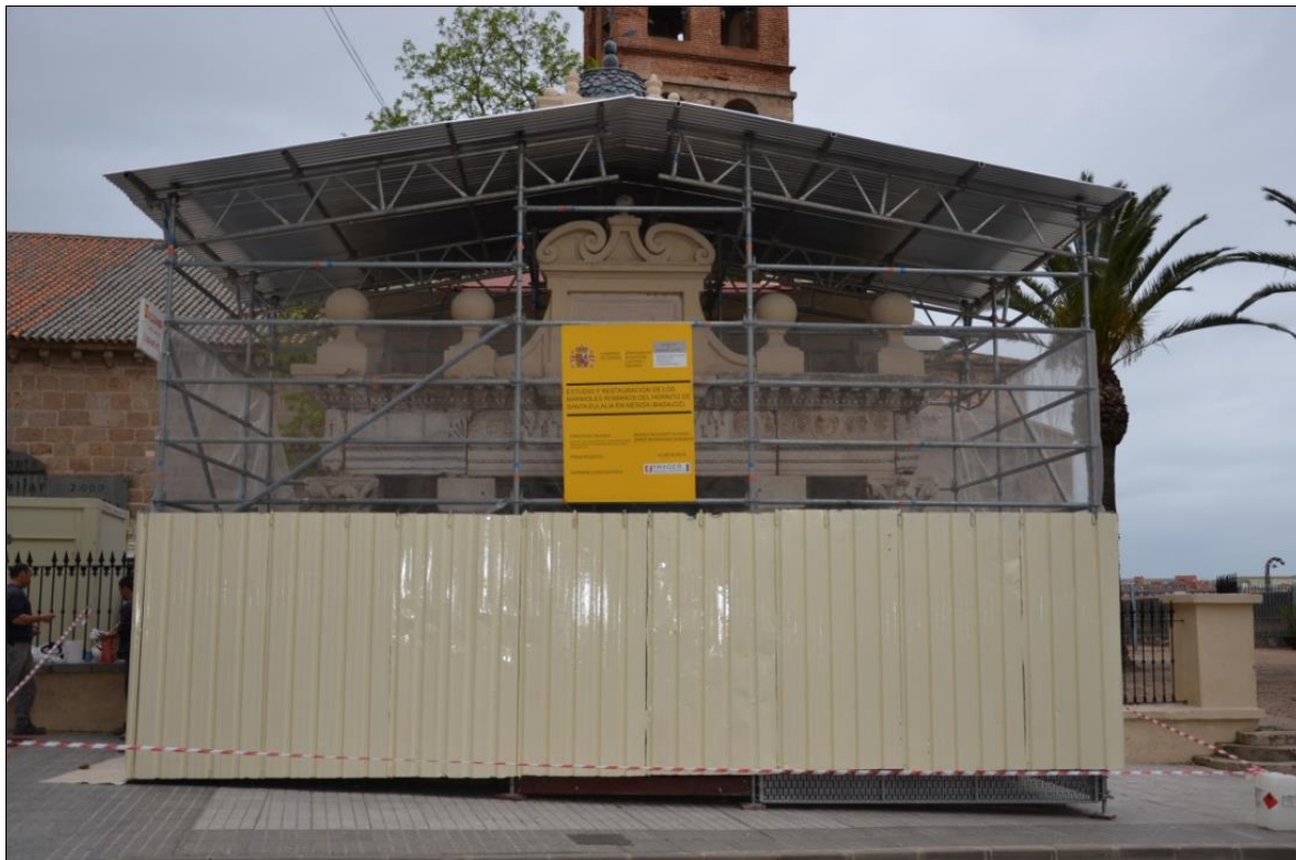
Restauración del Hornito de Santa Eulalia (Mérida)
