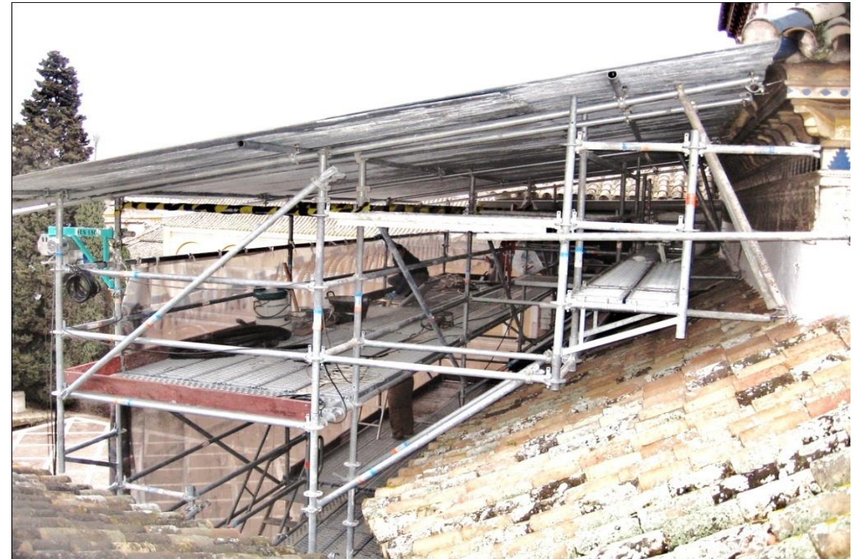
Restauración de la Puerta de Pedro I Real Alcázar de Sevilla
